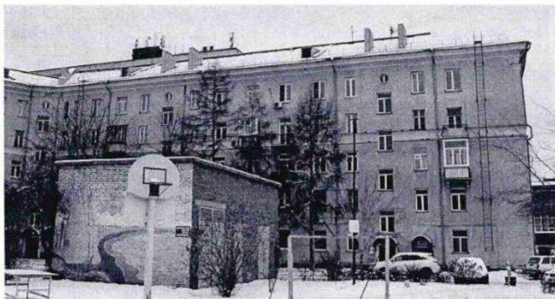
6. Восточный (внутренний) фасад.
