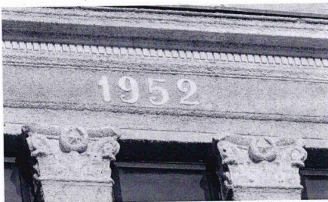
31. Архитектурно-художественное оформление центральной части юго-западного фасада. Ложное окно, рельефные цифры, капители композитного ордера.
