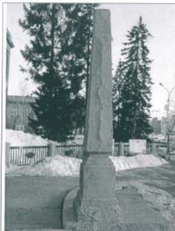
19. Дефекты отделки обелиска.
