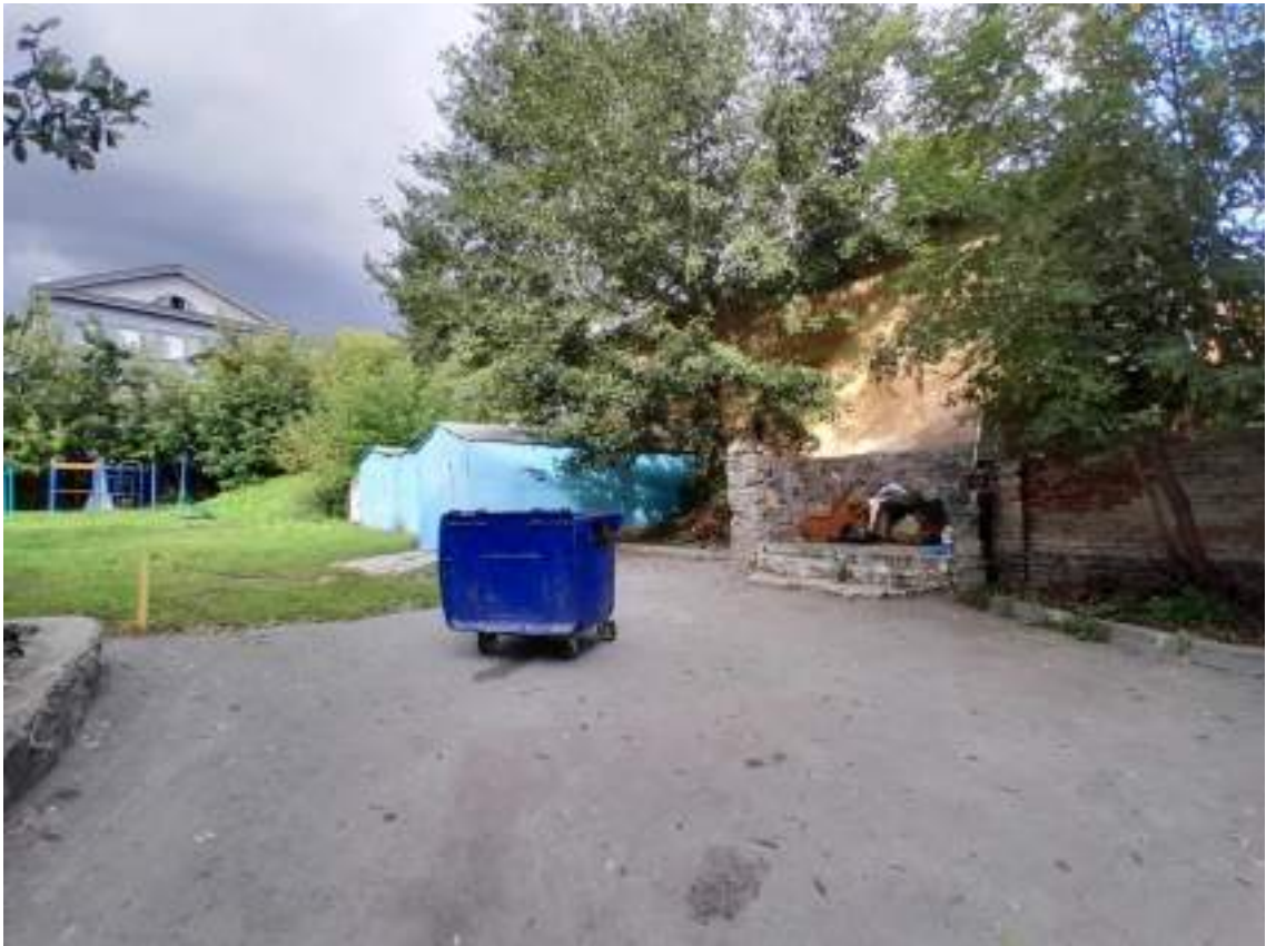
Фото 28. Вид на дисгармоничное сооружение для сбора мусора и дисгармоничные металлические гаражи, имеющие внутриквартальное положение. Фото 2023 г.
