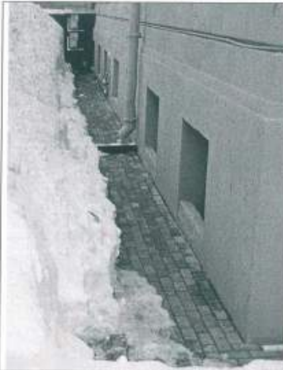
6. Фрагмент цоколя (цокольного этажа) восточного (глиняного) фасада. Вид приемков и отмостки.
