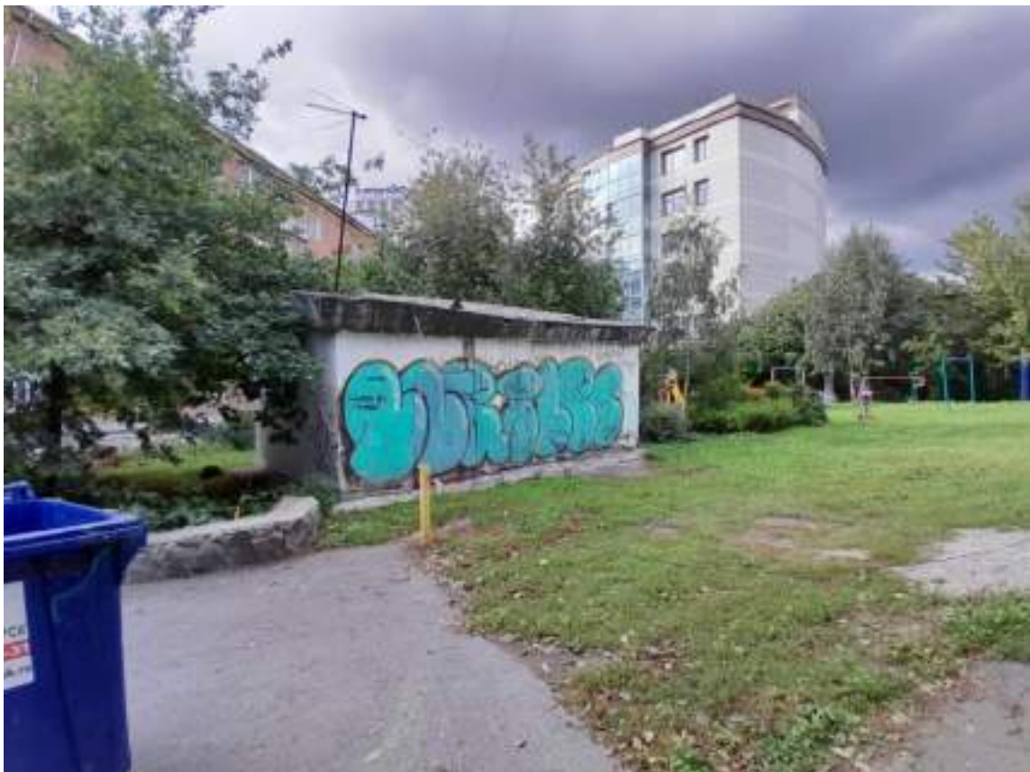
Фото № 14. Вид на дисгармоничное хозяйственное сооружение на территории жилого дома по ул. Советская, 4. Фото от 07.09.2023 г.
