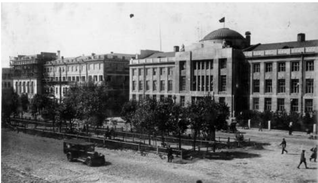
Фото 11. Вид с Красного проспекта на здание Сибревкома и здание бывшего реального училища во время реконструкции. Фото 1929 г.
