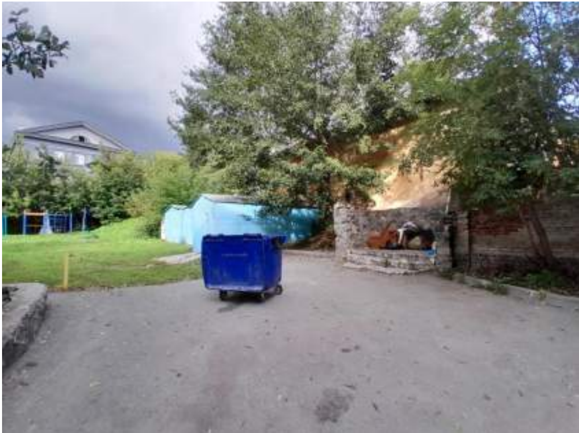
Фото № 13. Вид на дисгармоничные гаражи, помойку и зелёные насаждения со стороны проезда на территории жилого дома по ул. Советская, 4. Фото от 07.09.2023 г.
