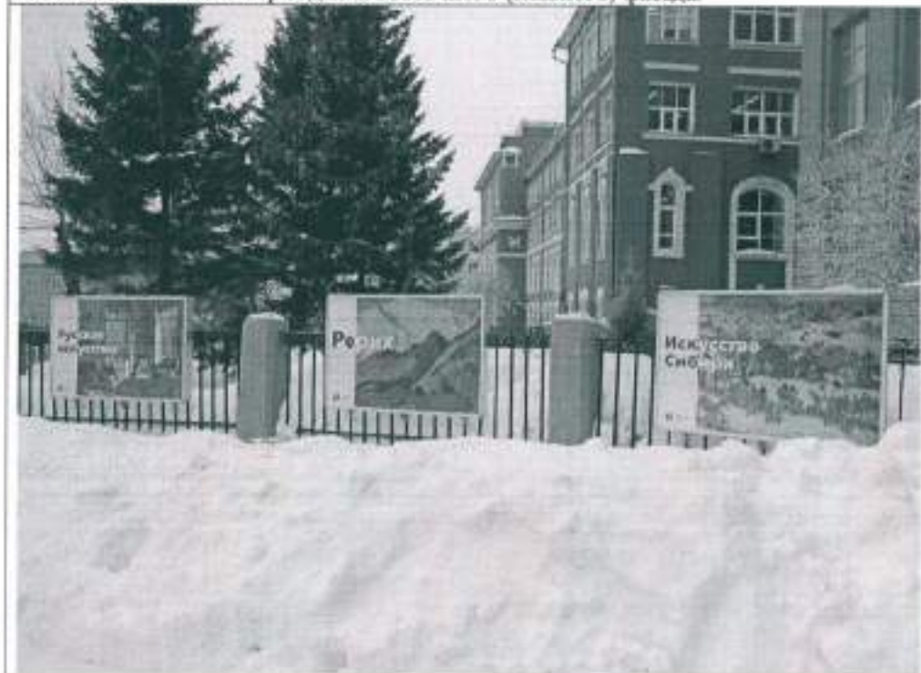
Фото 6. Левая часть ограждения восточного (главного) фасада.
