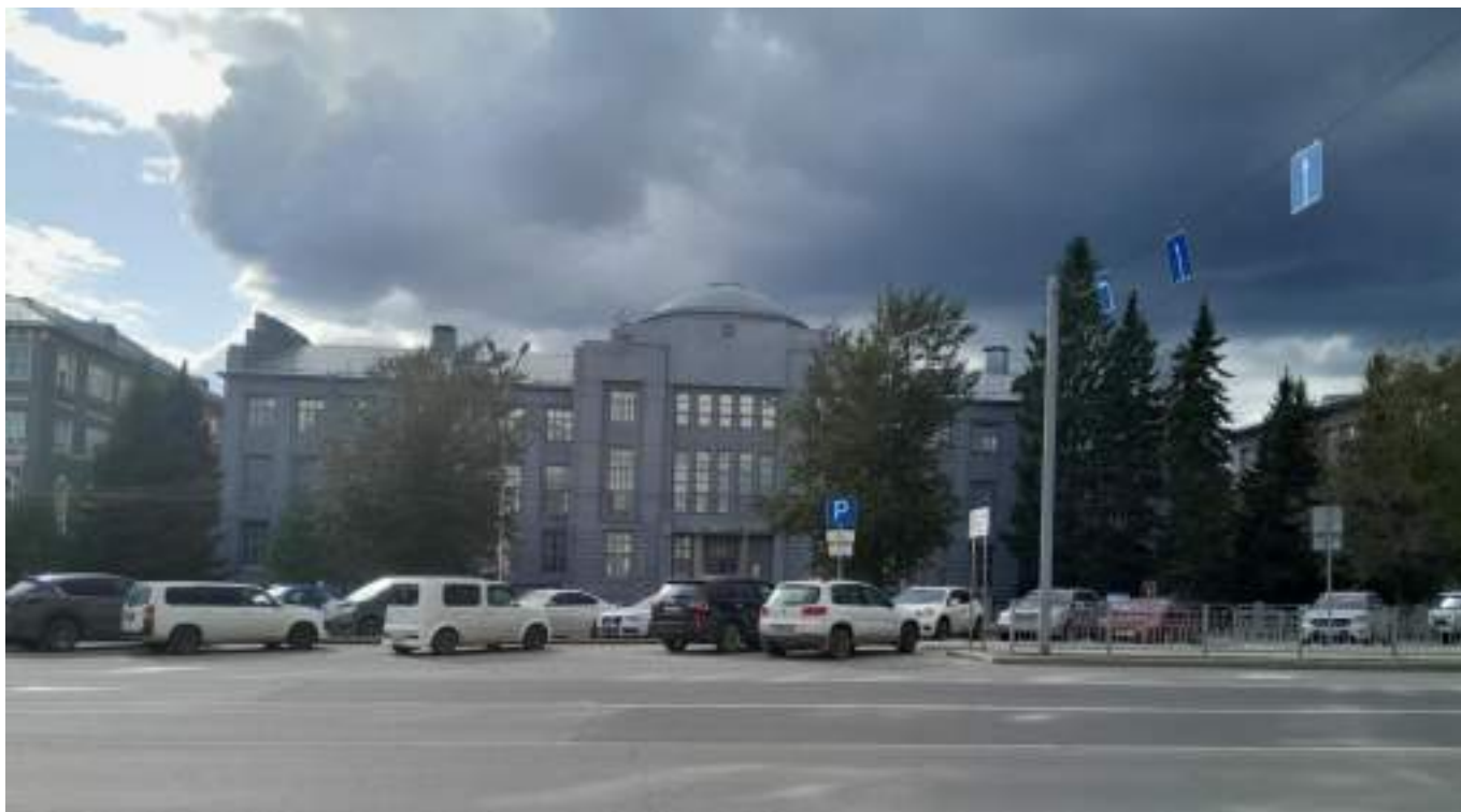
Фото 30. Вид на главный (восточный) фасад. Фото 2023 г.
