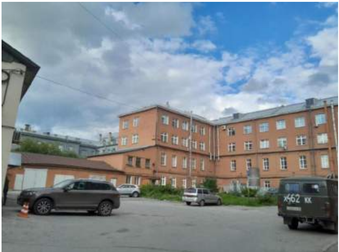
Фото № 48. Вид на внутреннюю территорию объекта культурного наследия регионального значения «Дом №3 по Красному проспекту. Областная больница». Фото от 07.09.2023 г.
