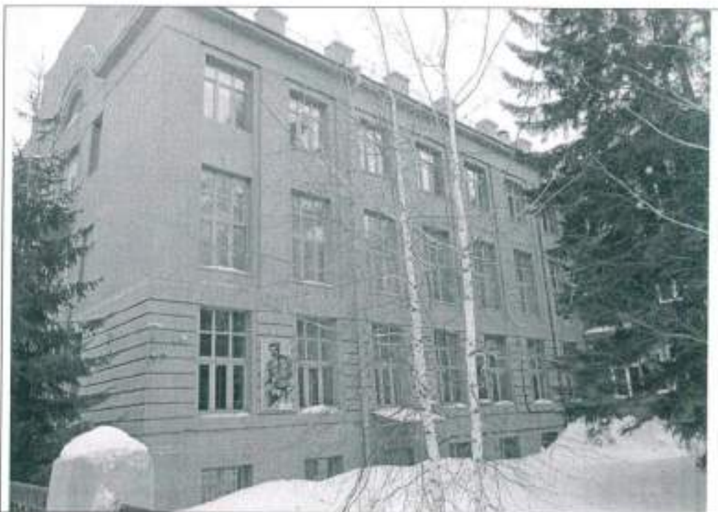
4. Северное крыло западного фасада.
