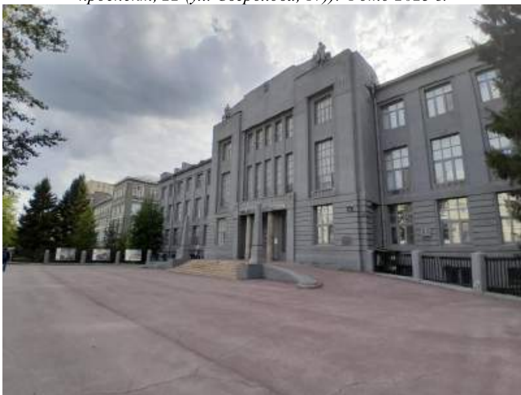
Фото 18. Вид на главный фасад и входную группу объекта культурного наследия федерального значения — памятник «Дом областных организаций» (Красный проспект, 5). Фото 2023 г.
