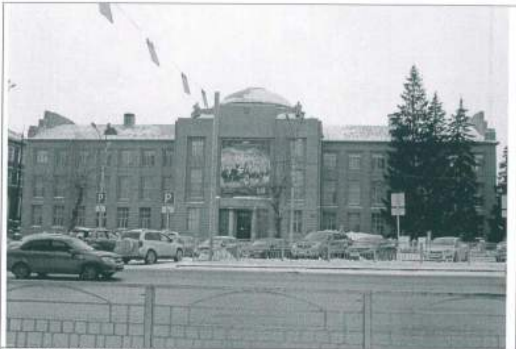
1. Главный (восточный) фасад.
