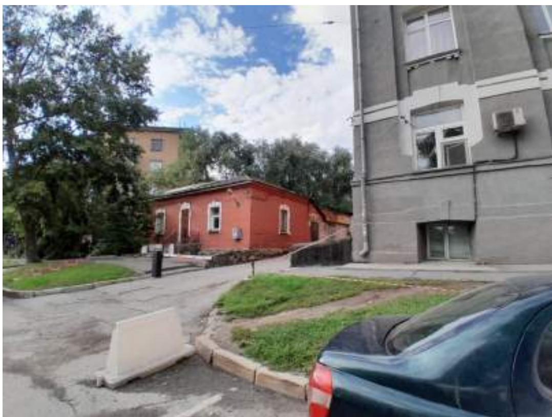
Фото 26. Вид на проходную КПП на территорию больницы со стороны ул. Спартака (нейтральная застройка). Фото 2023 г.
