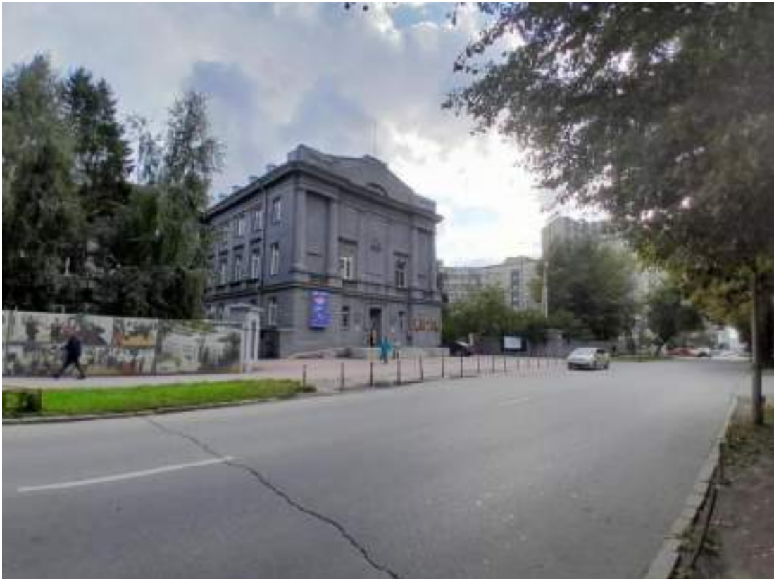
Фото № 33. Вид на главный фасад пристройки объекта культурного наследия федерального значения «Дом областных организаций» с нечётной стороны ул. Свердлова.
