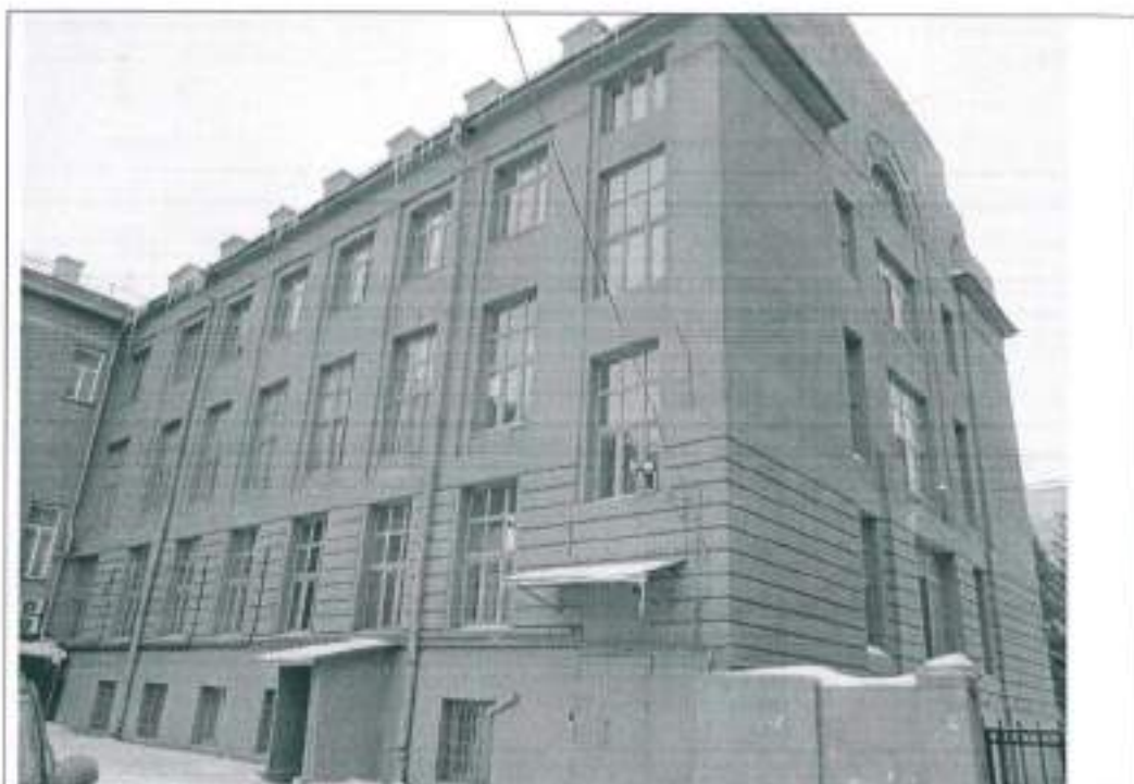
5. Южное крыло западного фасада.
