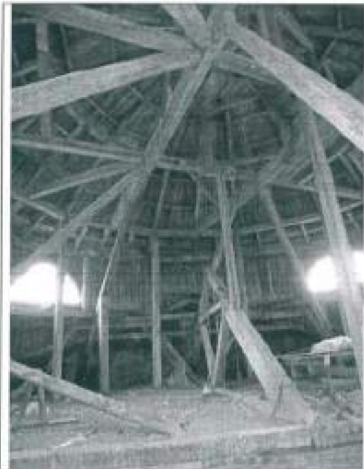
14. Конструкция барабана и купола.
