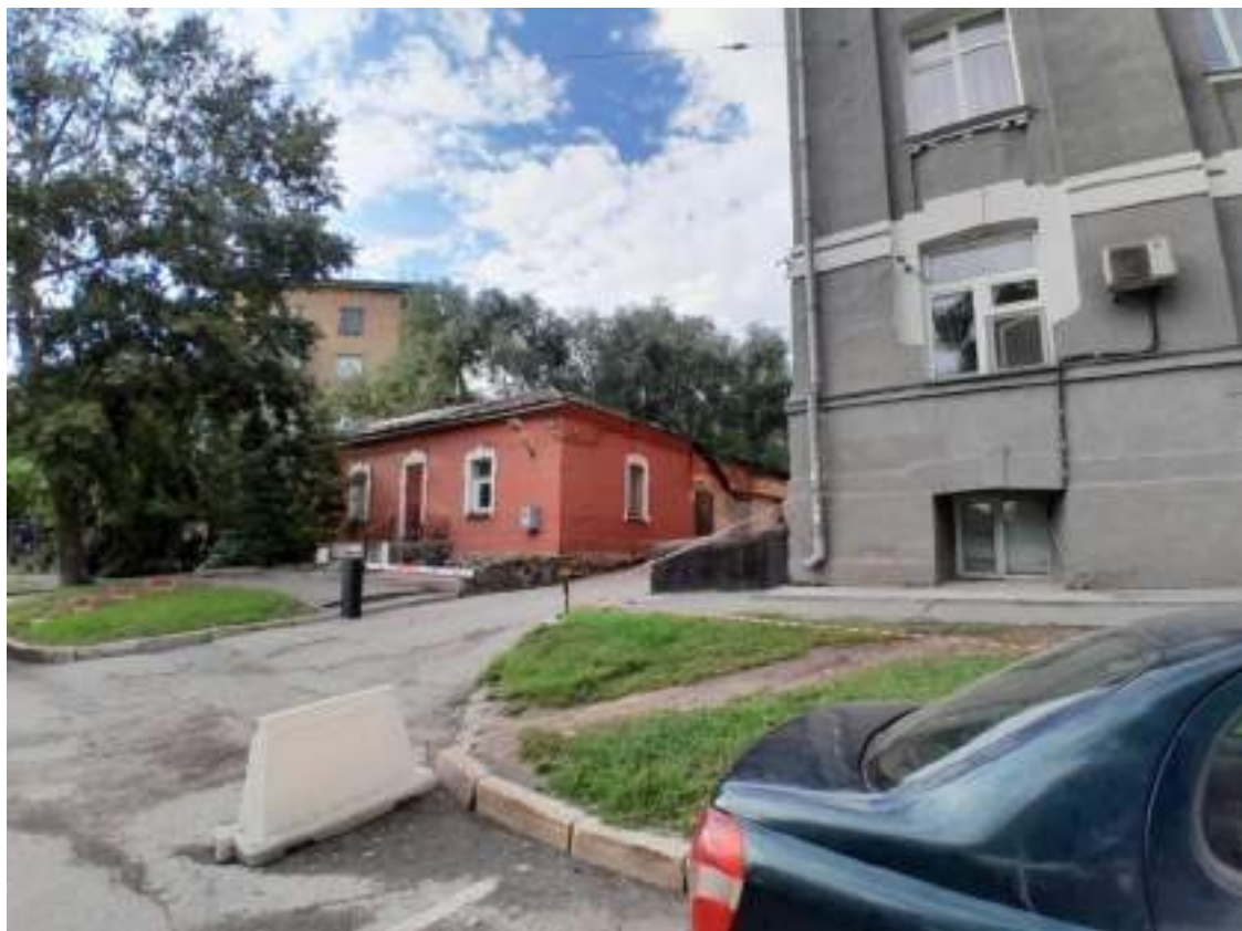
Фото № 46. Вид на КПП и въезд на территорию объекта культурного наследия регионального значения «Дом №3 по Красному проспекту. Областная больница», расположенного по адресу Красный проспект, 3. Фото от 07.09.2023 г.
