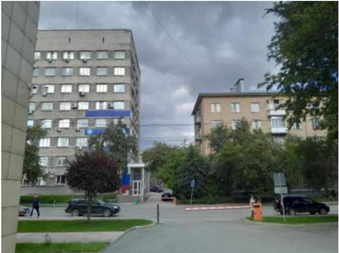
Фото № 21. Вид на проулок между жилым домом по ул. Советская, 4 и административным зданием по ул. Советская, 4а (ул. Свердлова, 8) со стороны ул. Советская (нейтральная застройка). Фото от 07.09.2023 г.
