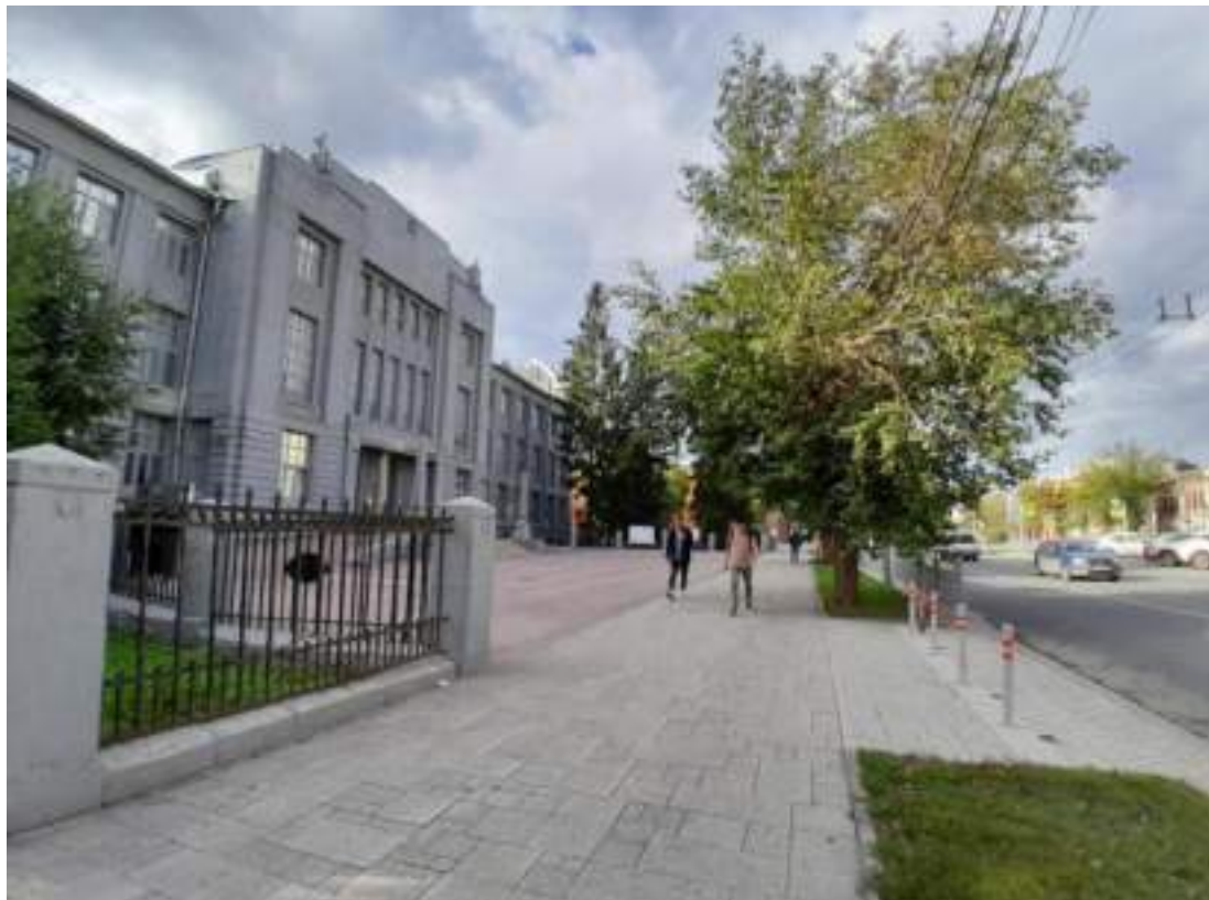
Фото № 38. Вид на главный фасад объекта культурного наследия федерального значения «Дом областных организаций», расположенного по адресу Красный проспект, 5. Фото от 07.09.2023 г.
