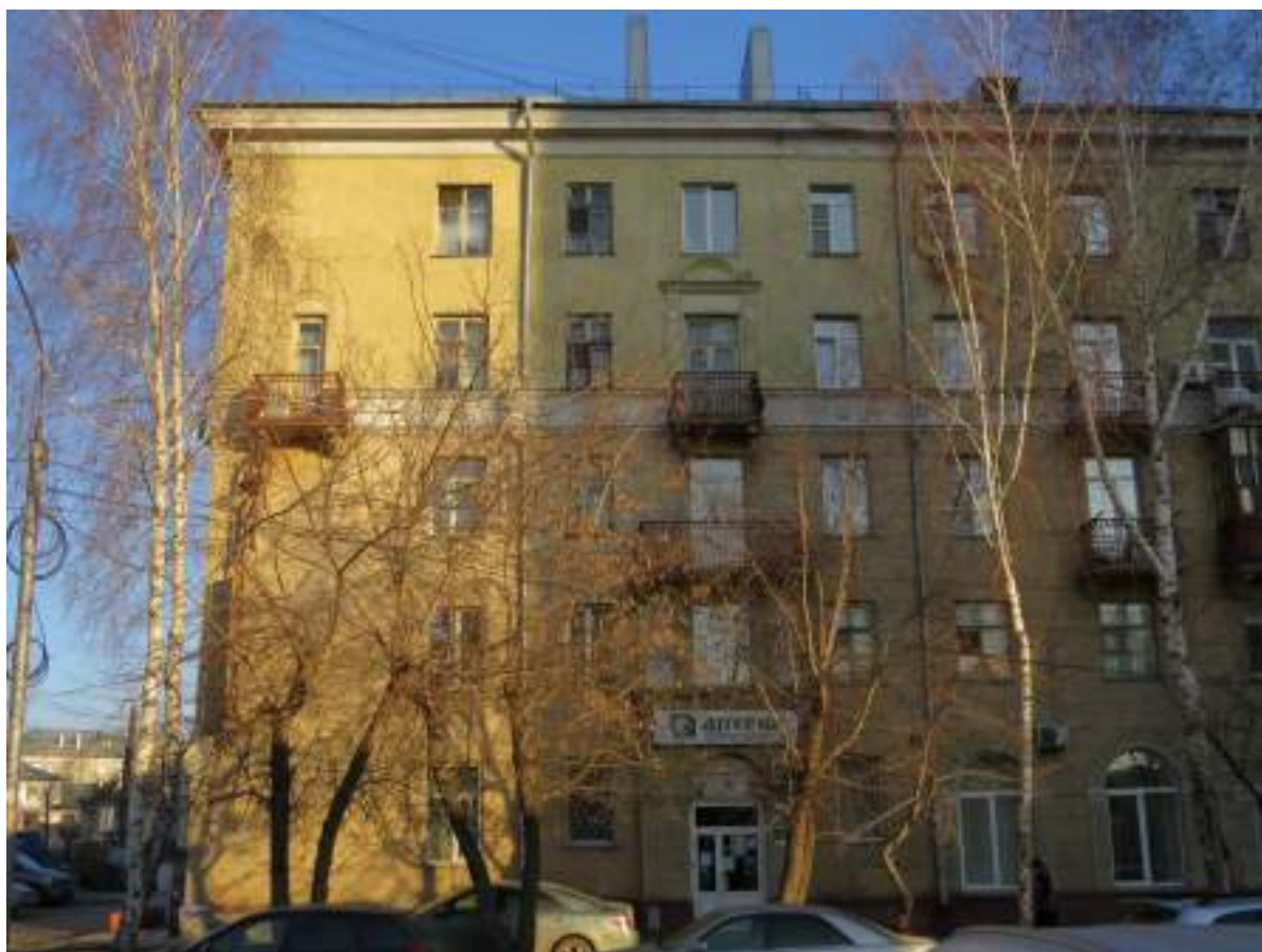
Фото 37. Фрагмент главного юго-западного фасада. Фото от 02.11.2023 г.
