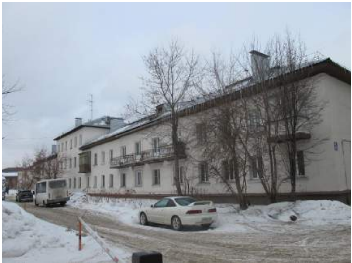
Фото № 40. Вид на проезд за жилым домом, расположенным по адресу пр. Дзержинского, 3б. Фото от 29.02.2024 г.
