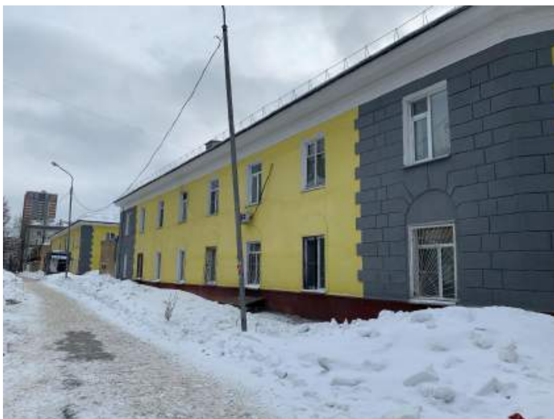
Фото № 16. Вид на общежитие, расположенное по адресу ул. Шекспира, 11, с перекрестка улиц Шекспира и Промышленная. Фото от 29.02.2024 г.
