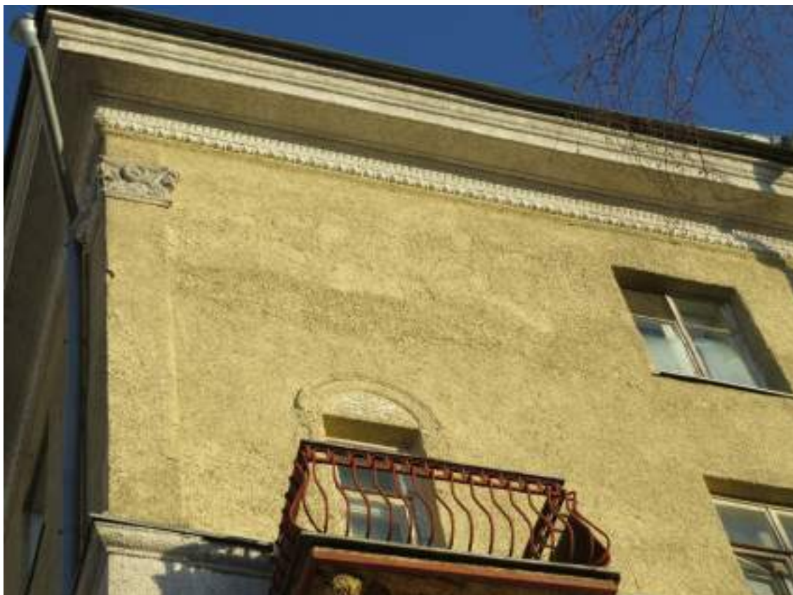
Фото 40. Фрагмент западного фасада. Фото от 02.11.2023 г.
