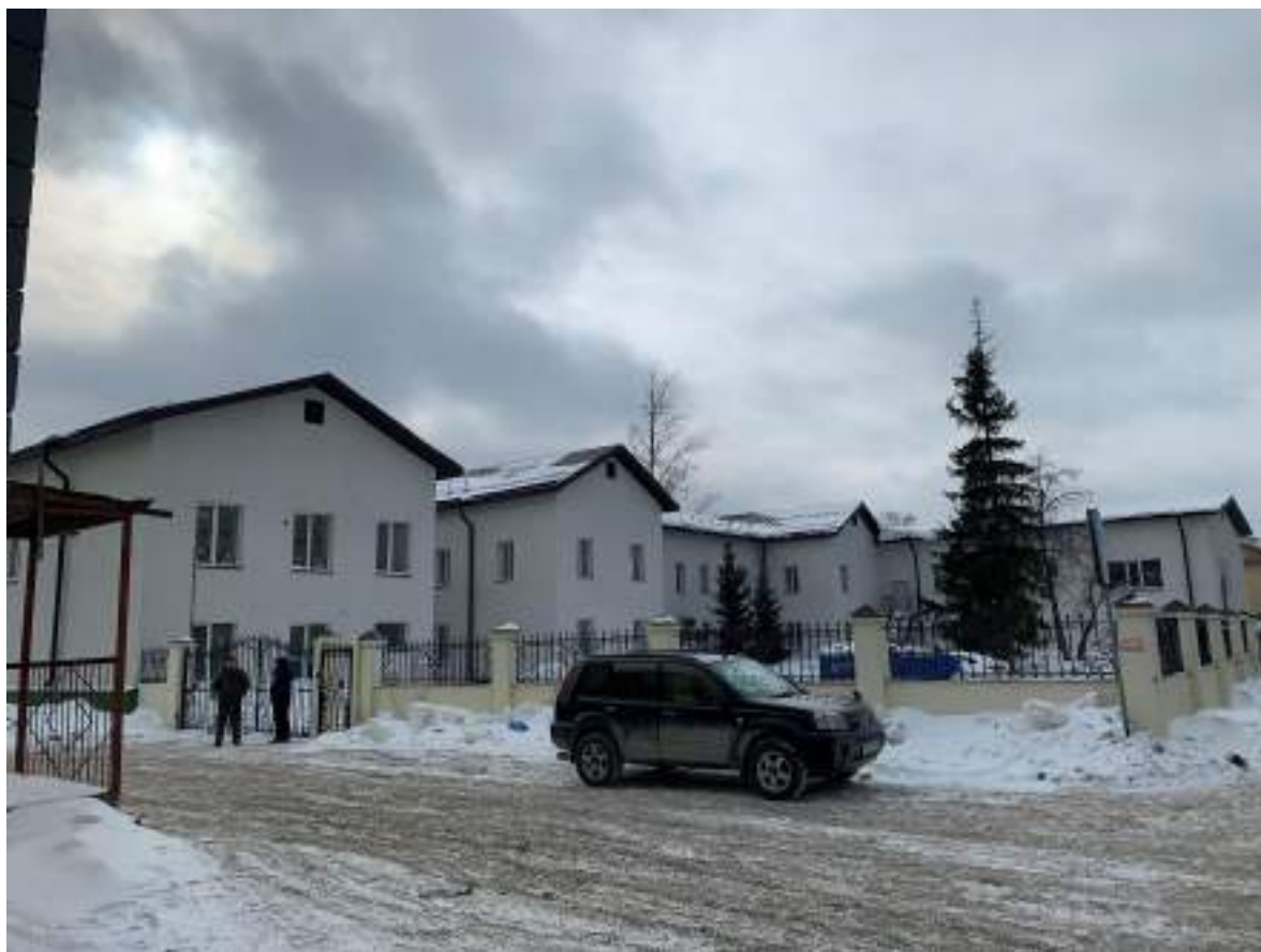
Фото 27. Вид на административное здание, расположенное по адресу ул. Промышленная, 4а, вид со стороны внутриворотового проезда. Фото 2024 г.
