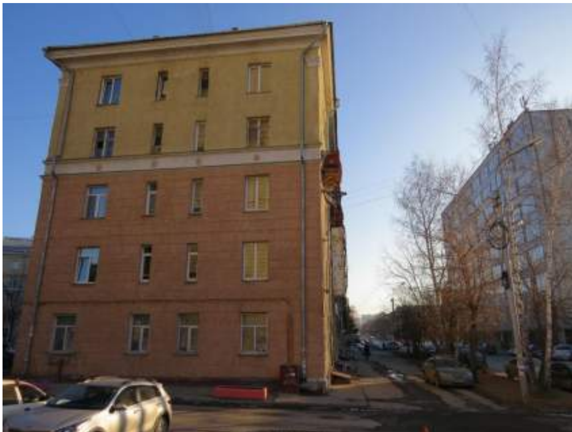
Фото 39. Вид на северный фасад. Фото от 02.11.2023 г.
