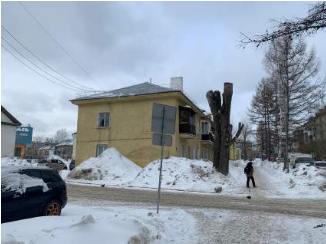
Фото № 9. Вид на жилой дом, расположенный по адресу ул. Шекспира, 7, со стороны жилого дома, расположенного по адресу пр. Дзержинского, 5. Фото от 29.02.2024 г.
