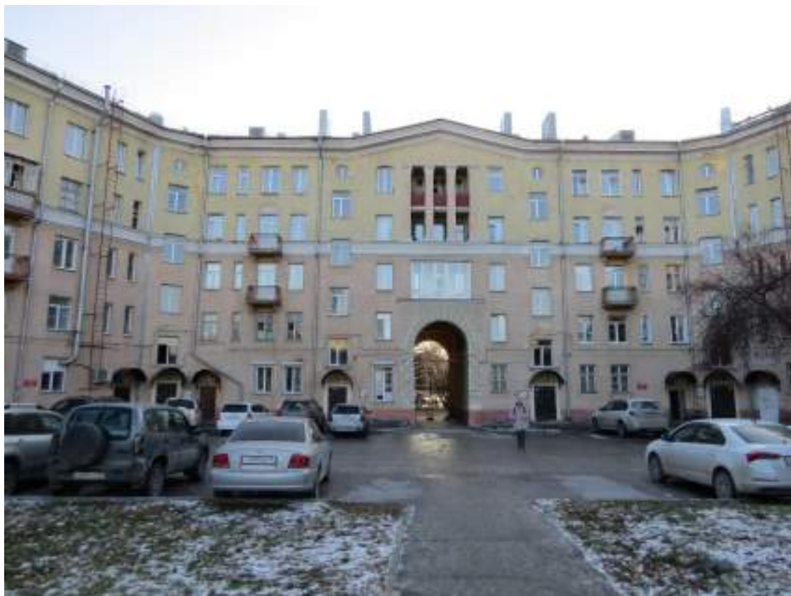
Фото 41. Вид на дворовый северо-восточный фасад с прилегающей территорией. Фото от 02.11.2023 г.
