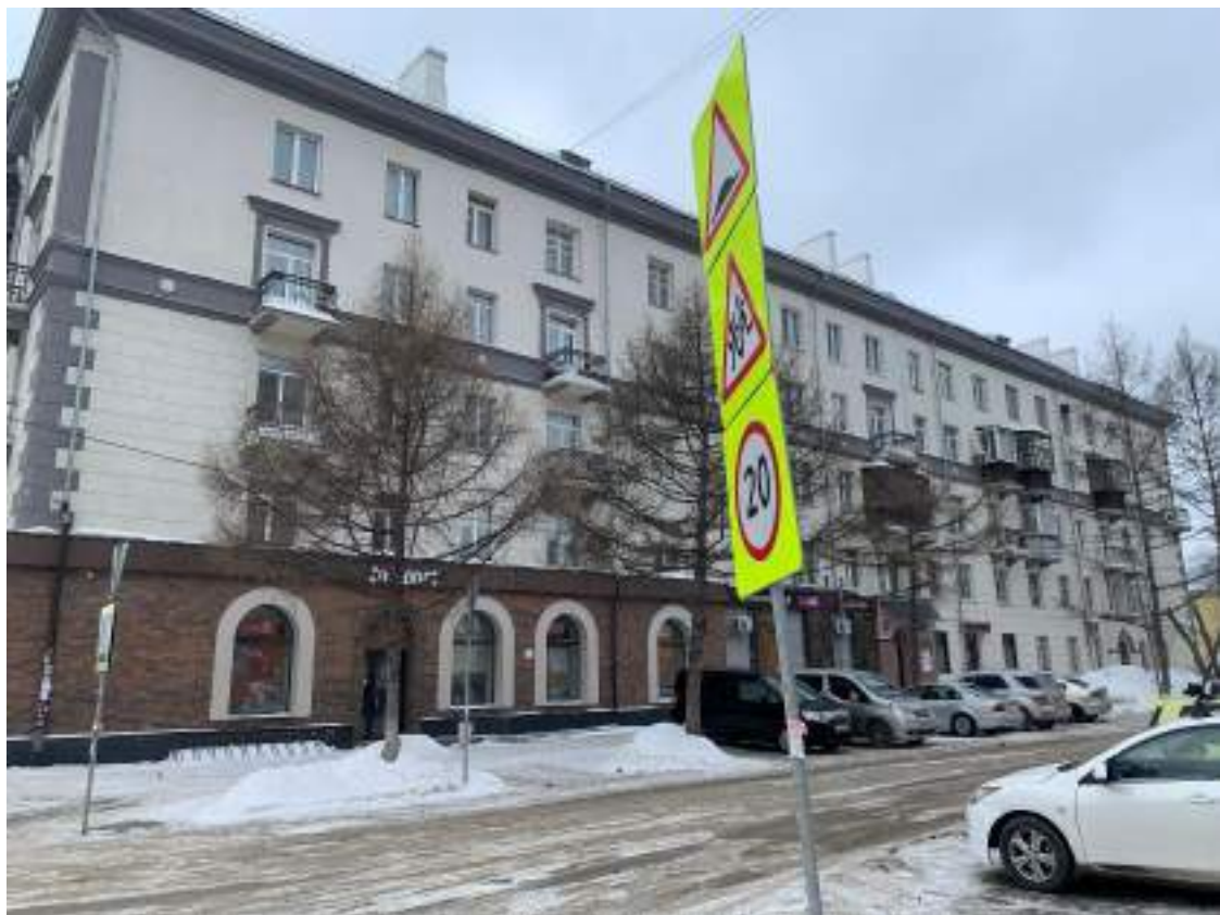
Фото № 8. Вид на жилой дом, расположенный по адресу пр. Дзержинского, 5, со стороны жилого дома, расположенного по адресу пр. Дзержинского, 7. Фото от 29.02.2024 г.
