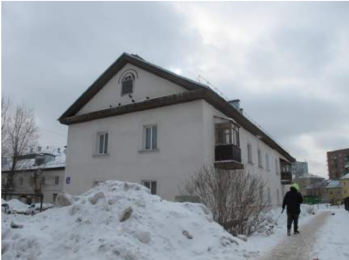
Фото № 45. Вид на фрагмент жилого дома, расположенного по адресу пр. Дзержинского, 3а. Фото от 29.02.2024 г.
