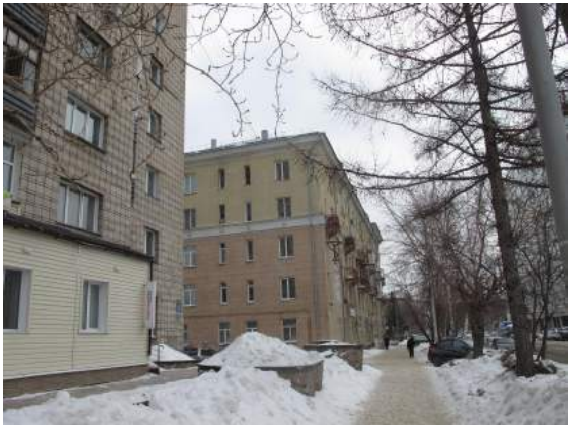
Фото № 30. Вид на жилые дома, расположенные по адресам ул. Красина, 68 и пр. Дзержинского, 1а, с четной стороны ул. Красина по направлению к пр. Дзержинского. Фото от 29.02.2024 г.
