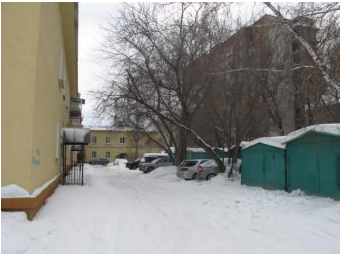
Фото № 62. Вид на западный фасад жилого дома, расположенного по адресу ул. Красина, 70а. Фото от 29.02.2024 г.
