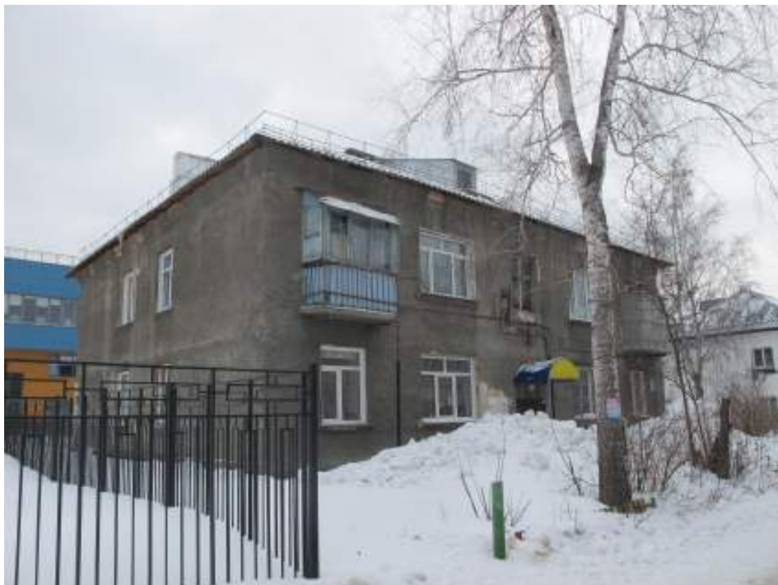
Фото № 53. Вид на северный фасад жилого дома, расположенного по адресу ул. Красина, 72в. Фото от 29.02.2024 г.
