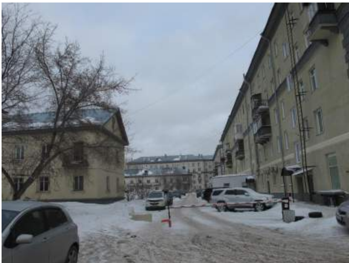
Фото № 38. Вид на внутриворотовое пространство между жилыми домами, расположенными по адресам пр. Дзержинского, 3 и 3а. Фото от 29.02.2024 г.
