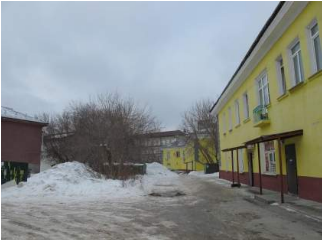
Фото № 47. Вид на внутридворовый проезд, расположенный за жилыми домами по адресам ул. Шекспира, 9 и 11. Фото от 29.02.2024 г.
