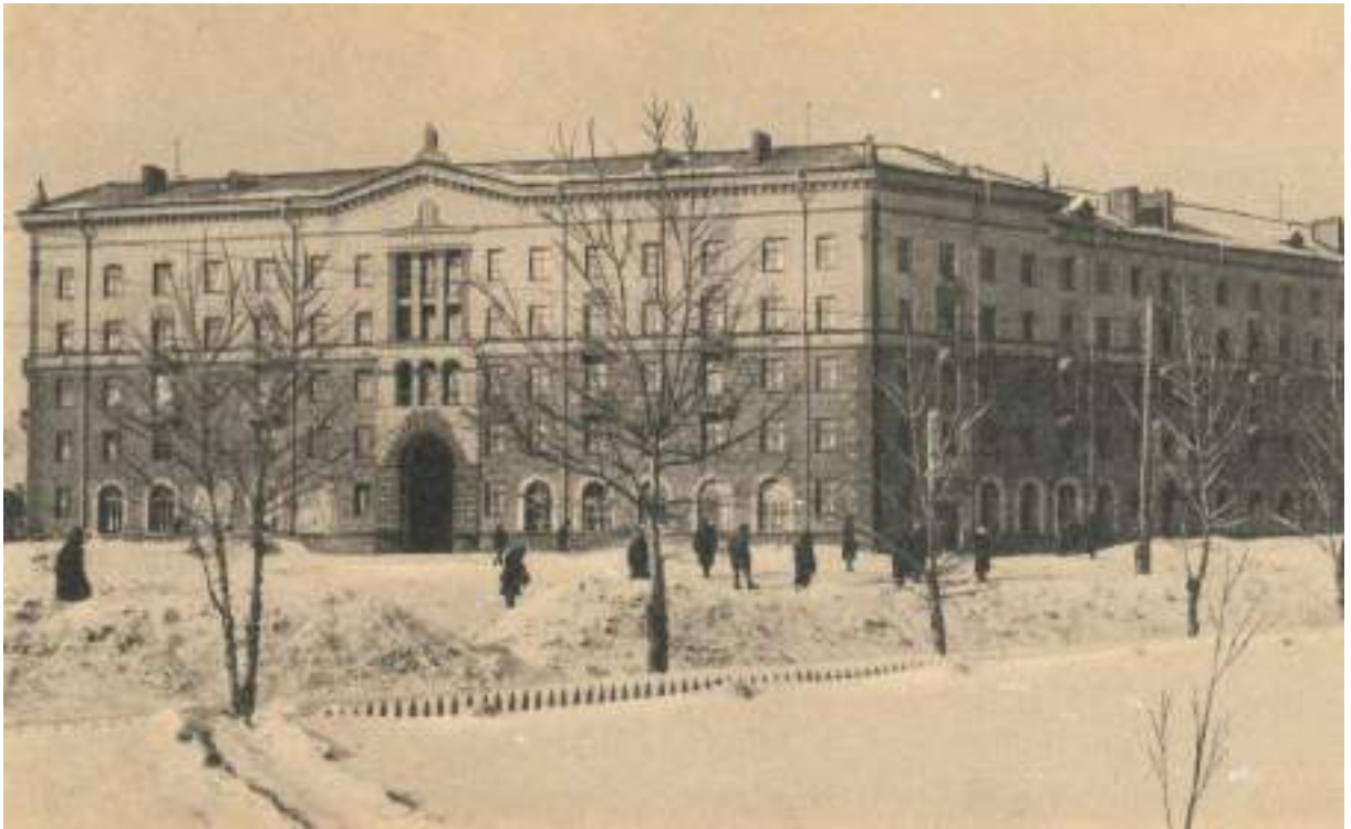
Фото 10. Фрагмент главного фасада жилого дома, расположенного по адресу проспект Дзержинского 1а, г. Новосибирск. Из книги «Новосибирск. История градостроительства 1945-1985 гг.». Автор С.Н. Баландин.
