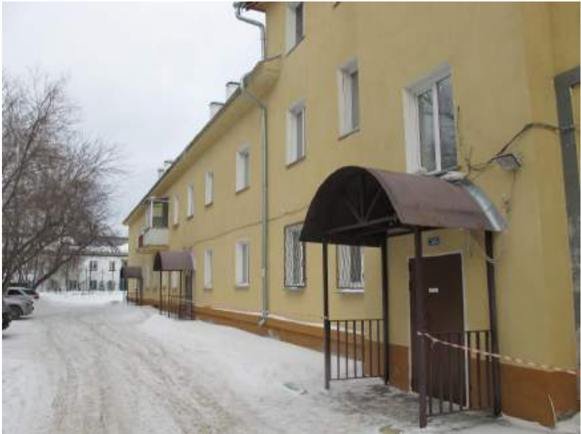
Фото № 61. Вид на западный фасад жилого дома, расположенного по адресу ул. Красина, 70а. Фото от 29.02.2024 г.
