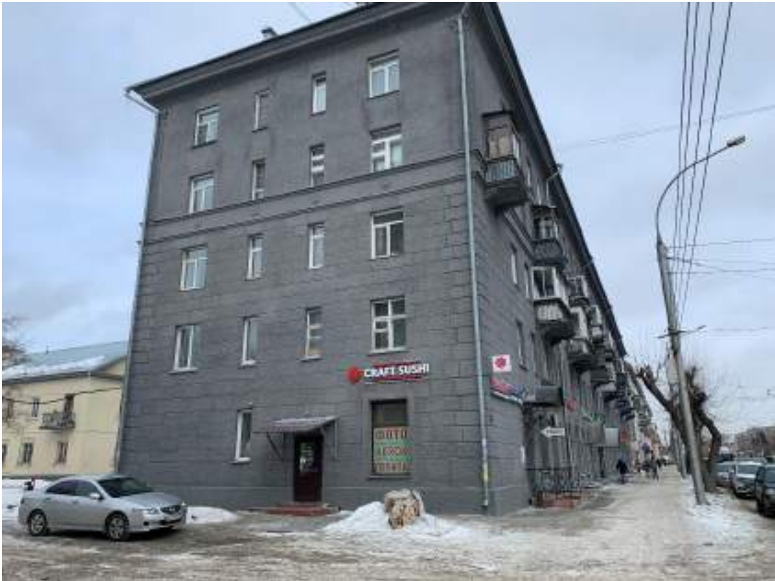
Фото № 5. Вид на жилой дом, расположенный по адресу пр. Дзержинского, 3, с нечетной стороны пр. Дзержинского. Фото от 29.02.2024 г.
