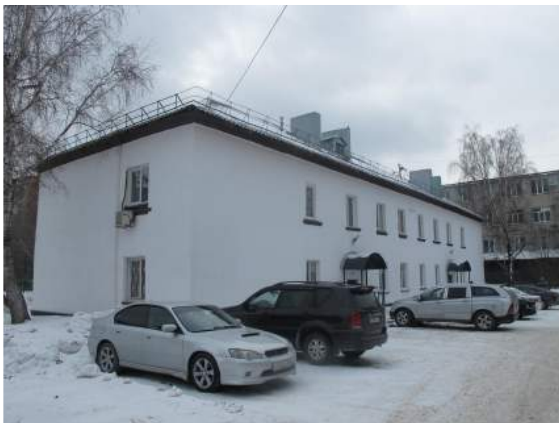
Фото № 54. Вид на северный и восточный фасады жилого дома, расположенного по адресу ул. Красина, 72г. Фото от 29.02.2024 г.
