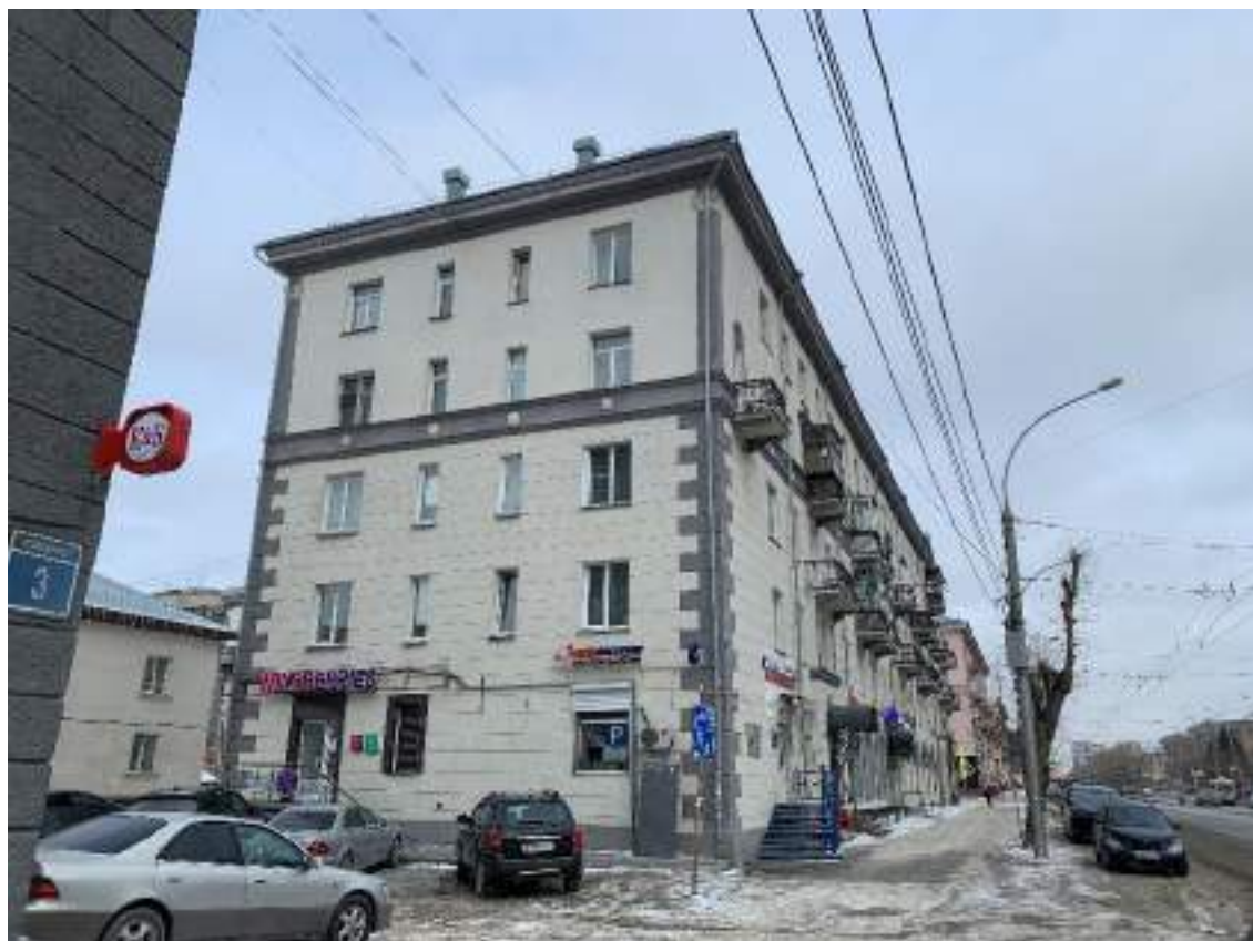
Фото 16. Вид на жилой дом, расположенный по адресу пр. Дзержинского, 5, вид с нечетной стороны пр. Дзержинского. Фото 2024 г.
