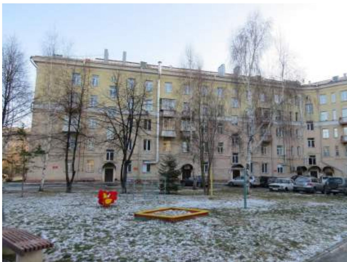
Фото 42. Вид на дворовый северо-западный фасад с прилегающей территорией. Фото от 02.11.2023 г.
