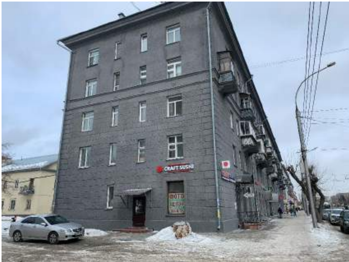
Фото 15. Вид на жилой дом, расположенный по адресу пр. Дзержинского, 3, вид с нечетной стороны пр. Дзержинского. Фото 2024 г.
