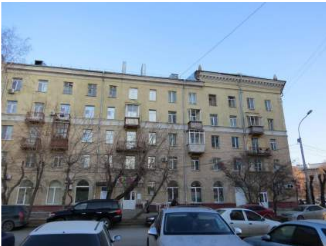
Фото. 36. Фрагмент главного юго-западного фасада. Фото от 02.11.2023 г.
