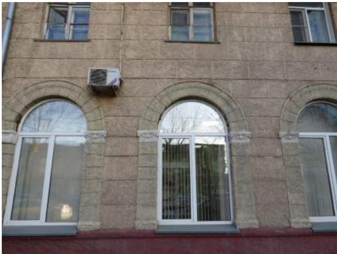
Фото 38. Фрагмент фасада. Окна-витрины первого этажа. Фото от 02.11.2023 г.
