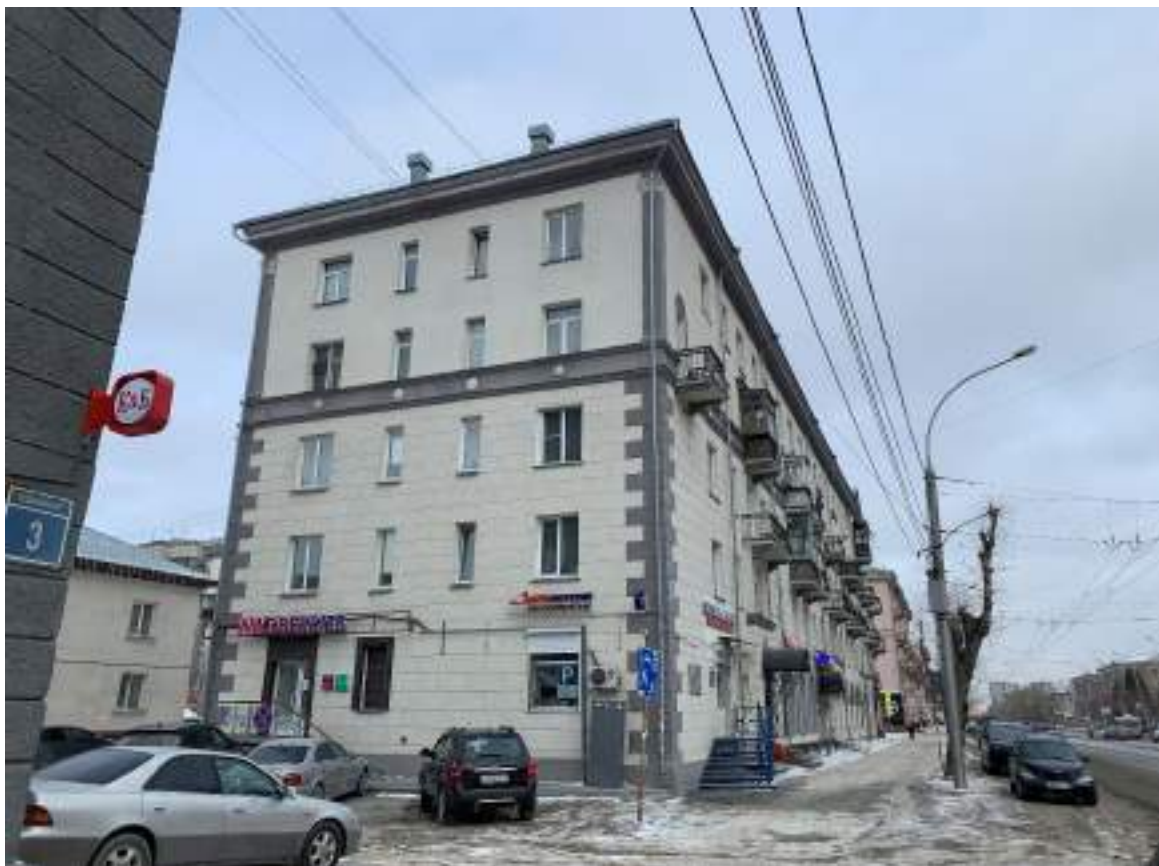
Фото № 6. Вид на жилой дом, расположенный по адресу пр. Дзержинского, 5, с нечетной стороны пр. Дзержинского. Фото от 29.02.2024 г.
