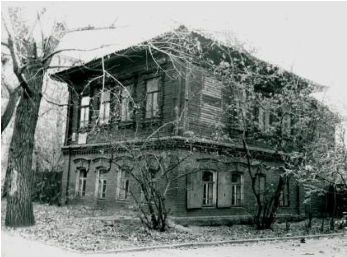
Рис. 16 Дом жилой Д.Е. Барабанова. Северный и восточный фасады. Фото октябрь 1980.
