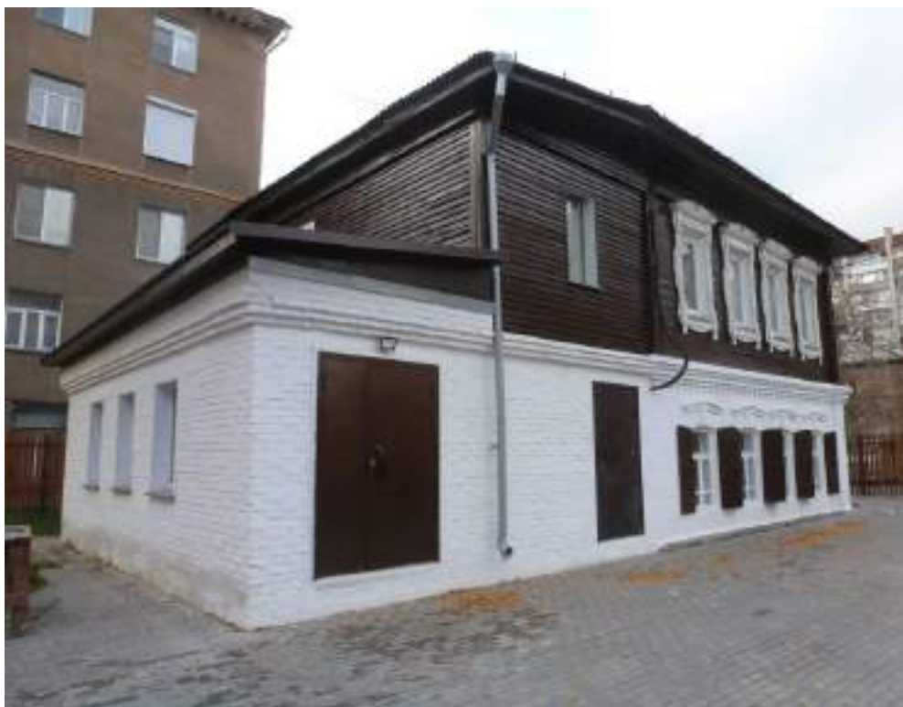
Рис. 28. Восточный и южный фасады объекта культурного наследия местного (муниципального) значения «Дом жилой Д.Е. Барабанова». Фото от 16.10.2020.
