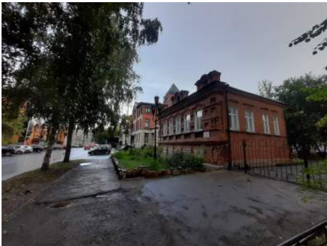
Фото 17. Вид на объект культурного наследия регионального значения «Двухэтажный кирпичный особняк». Вид на южный и восточный фасады. Фото от 05.09.2023 г.
