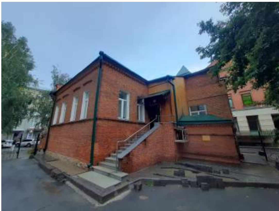
Фото 19. Вид на объект культурного наследия регионального значения «Двухэтажный кирпичный особняк». Вид на северный фасад. Фото от 05.09.2023 г.
