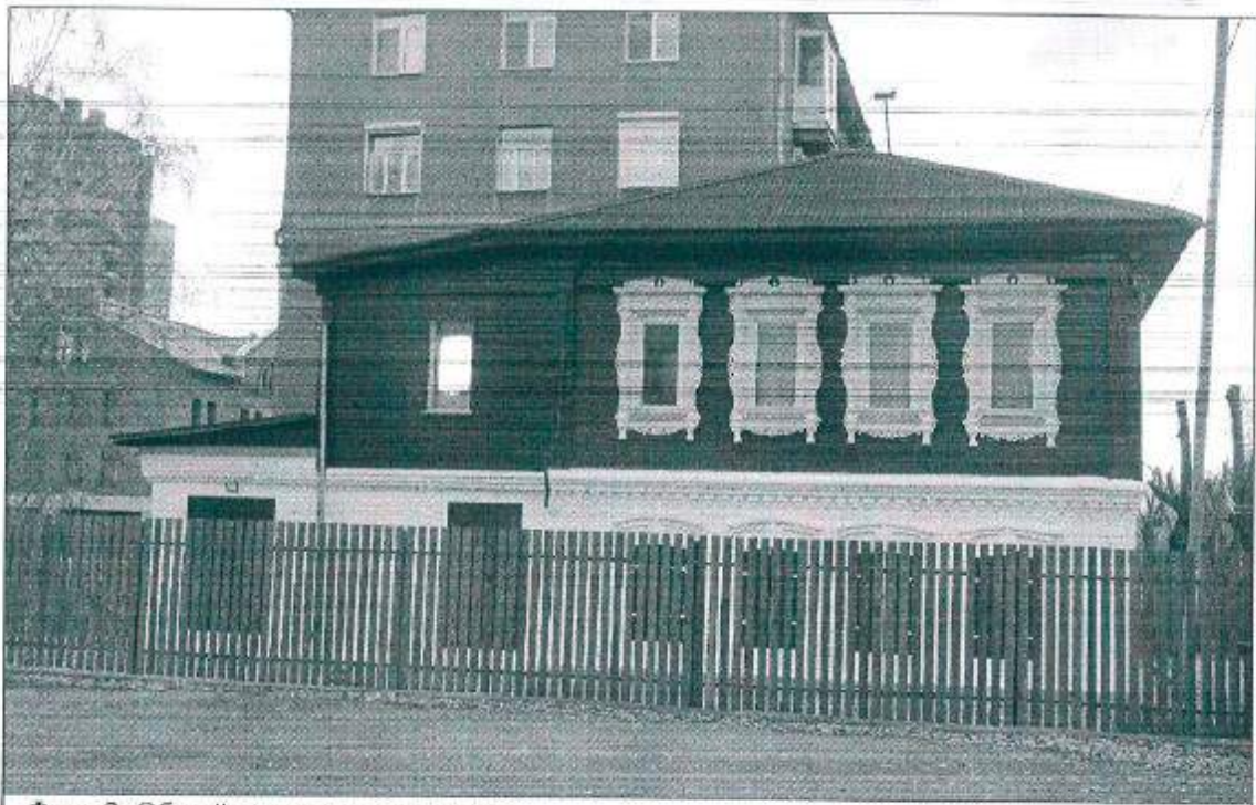
Фото 2. Общий вид здания с востока.
