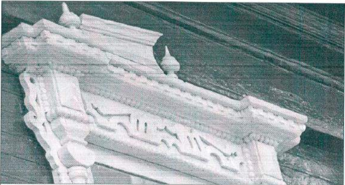
Фото 12. Фрагмент западного фасада.
