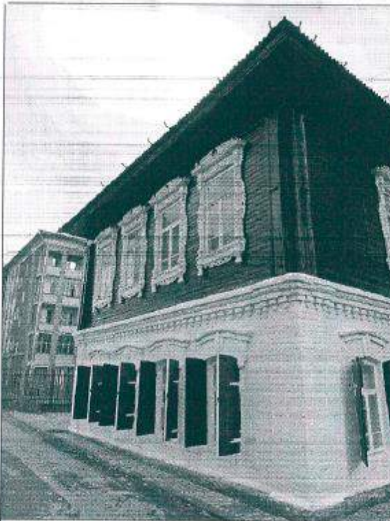
Фото 6. Главный (северный) фасад
