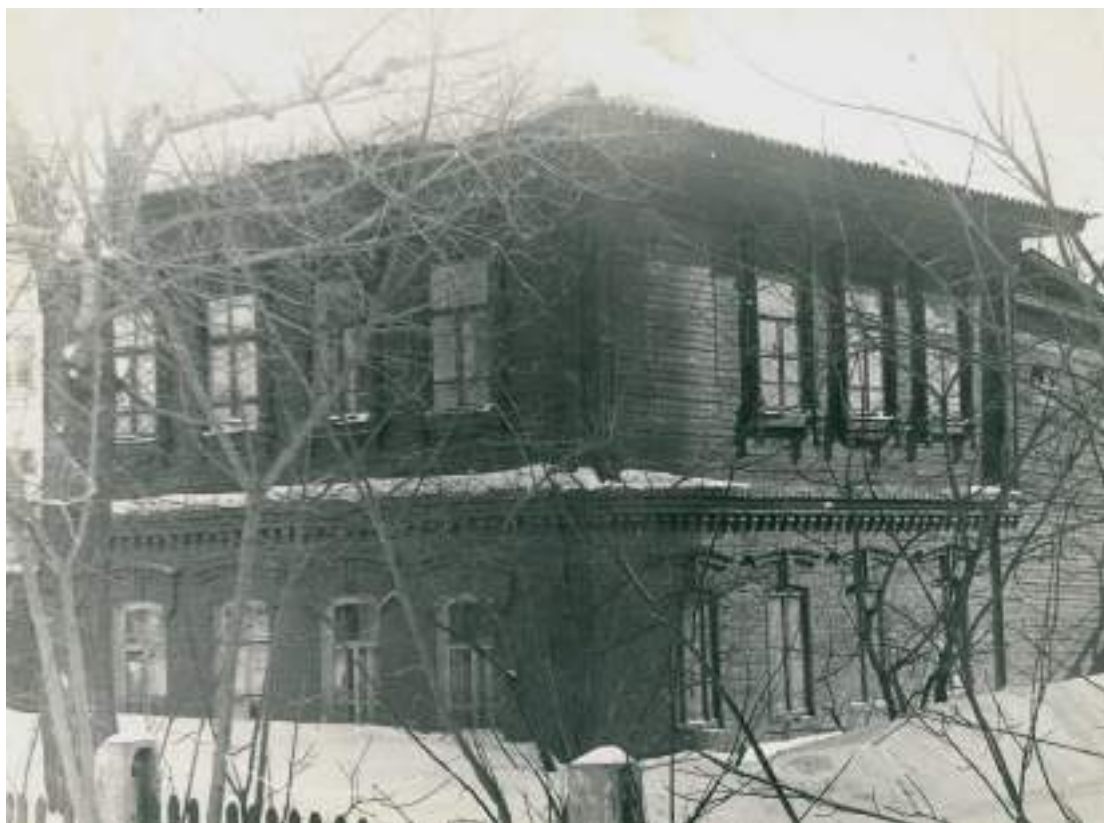
Рис. 14 Дом жилой Д.Е. Барабанова. Северный и западный фасады. Фото декабрь 1979.
