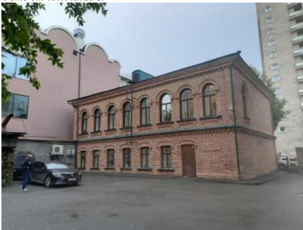
Фото 16. Вид на объект культурного наследия регионального значения «Двухэтажное кирпичное здание». Вид на северный фасад. Фото от 05.09.2023 г.
