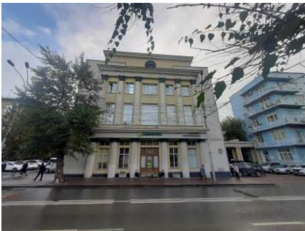
Фото 8. Вид на объект культурного наследия регионального значения «Облсберкасса и дом жилой». Вид на западный фасад. Фото от 05.09.2023 г.
