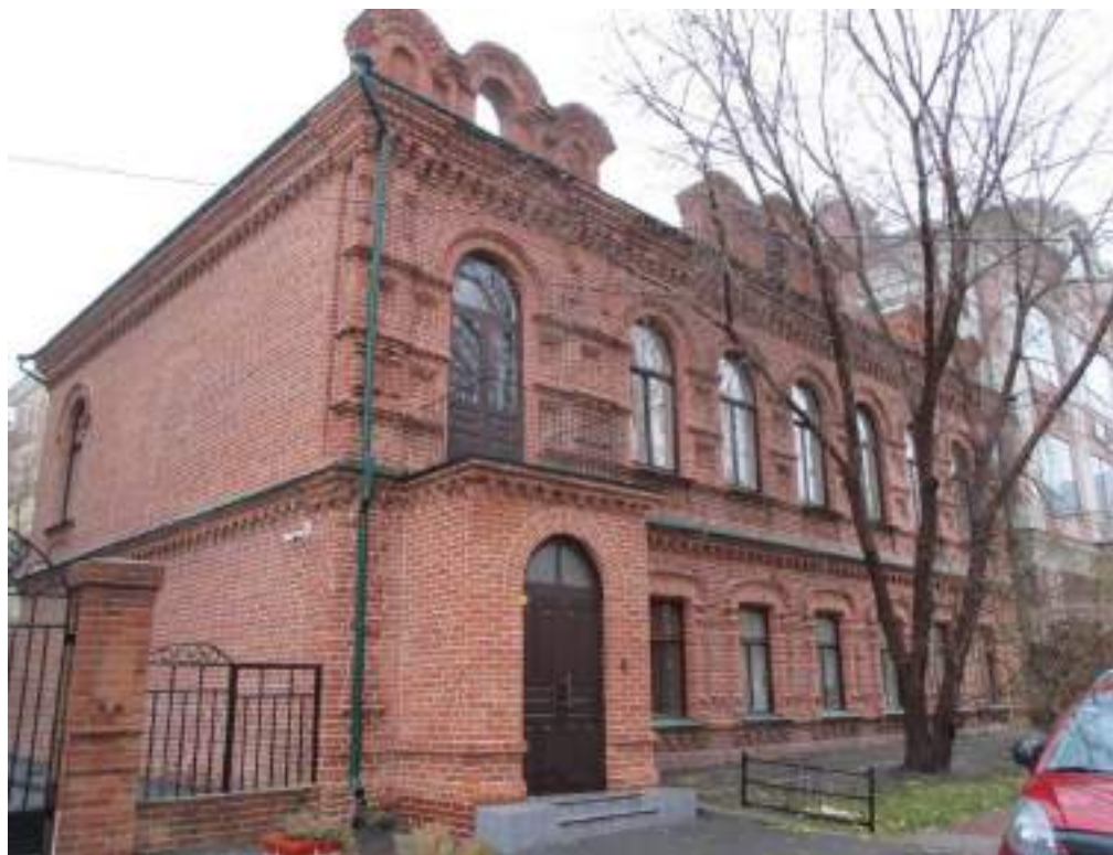
Рис. 32. Южный фасад объекта культурного наследия регионального значения «Двухэтажное кирпичное здание», расположенного по адресу: Новосибирская область, г. Новосибирск, Центральный район, ул. Ядринцевская, 19. Фото от 26.10.2020
