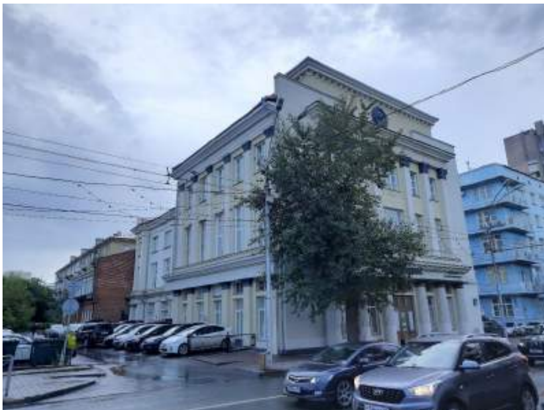
Фото 9. Вид на объект культурного наследия регионального значения «Облсберкасса и дом жилой». Вид на северный и западный фасады. Фото от 05.09.2023 г.
