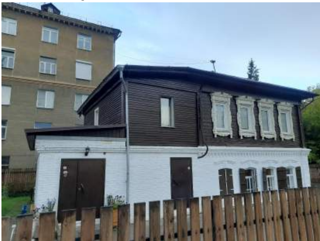
Фото 1. Вид на объект культурного наследия местного значения «Дом жилой Д.Е. Барабанова». Фото от 05.09.2023 г.
