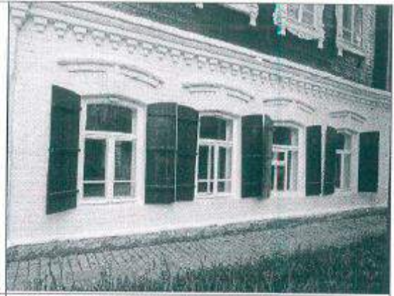
Фото 9. Фрагмент западного фасада.
