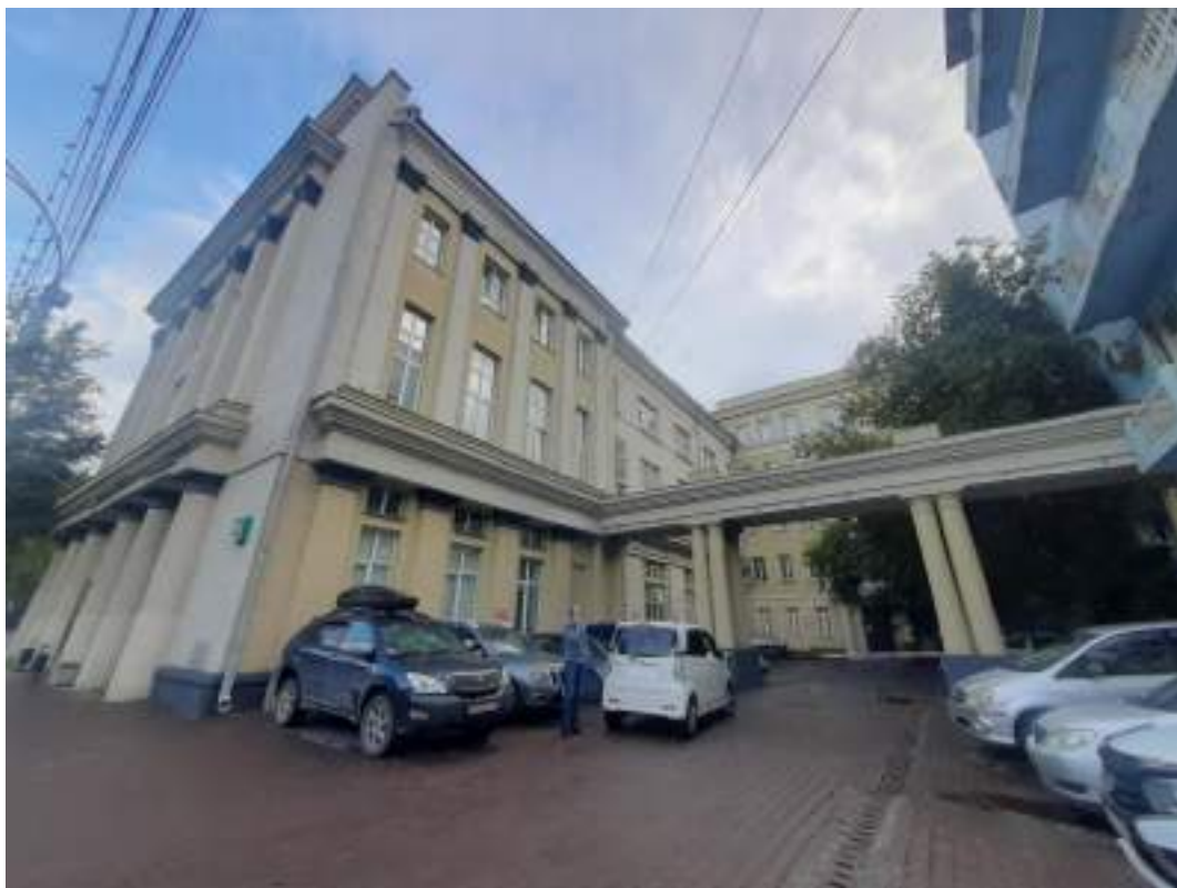
Фото 11. Вид на объект культурного наследия регионального значения «Облсберкасса и дом жилой». Вид со стороны внутриворотового проезда на южный фасад. Фото от 05.09.2023 г.
