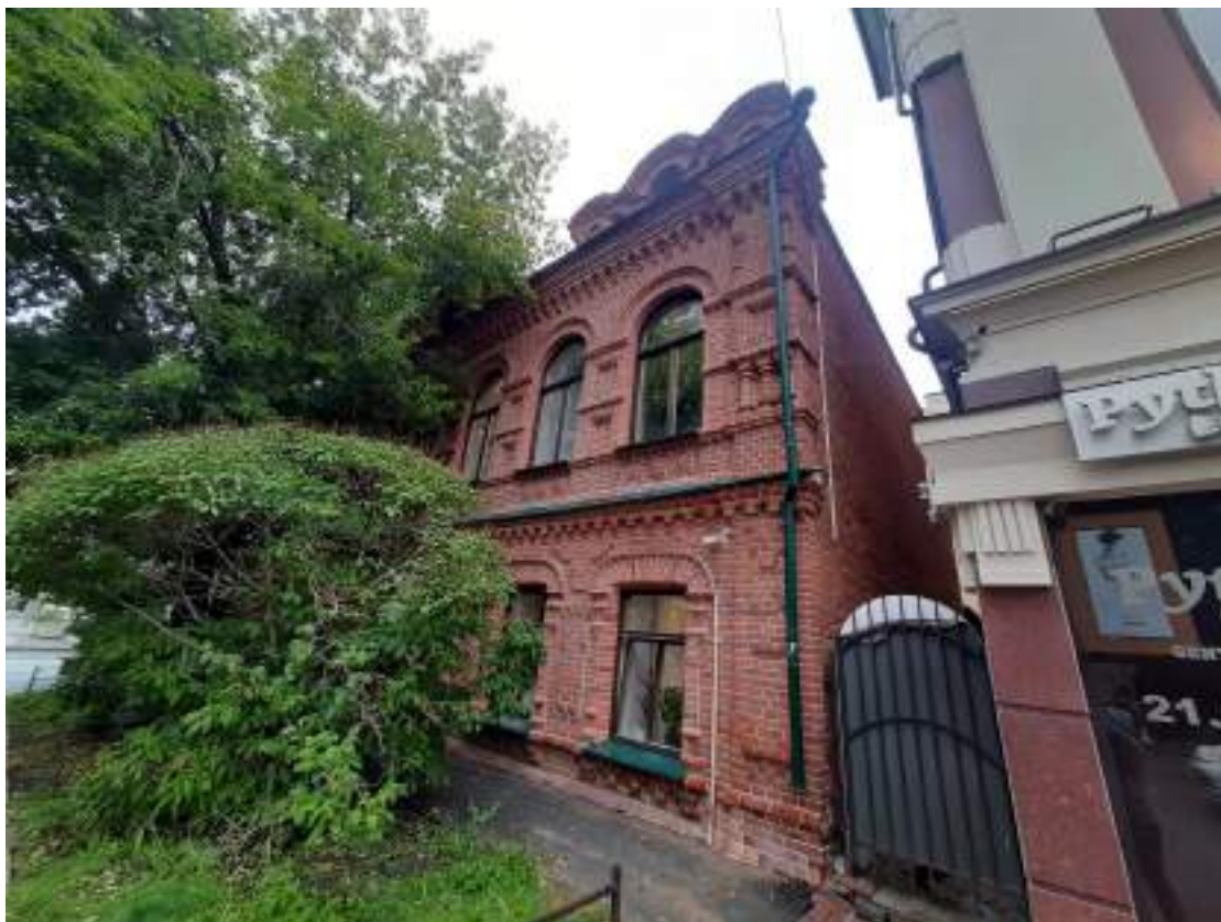
Фото 15. Вид на объект культурного наследия регионального значения «Двухэтажное кирпичное здание». Вид на южный фасад. Фото от 05.09.2023 г.
