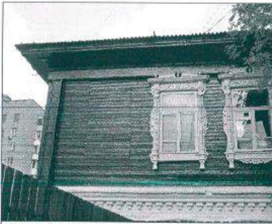
Фото 10. Фрагмент западного фасада.
