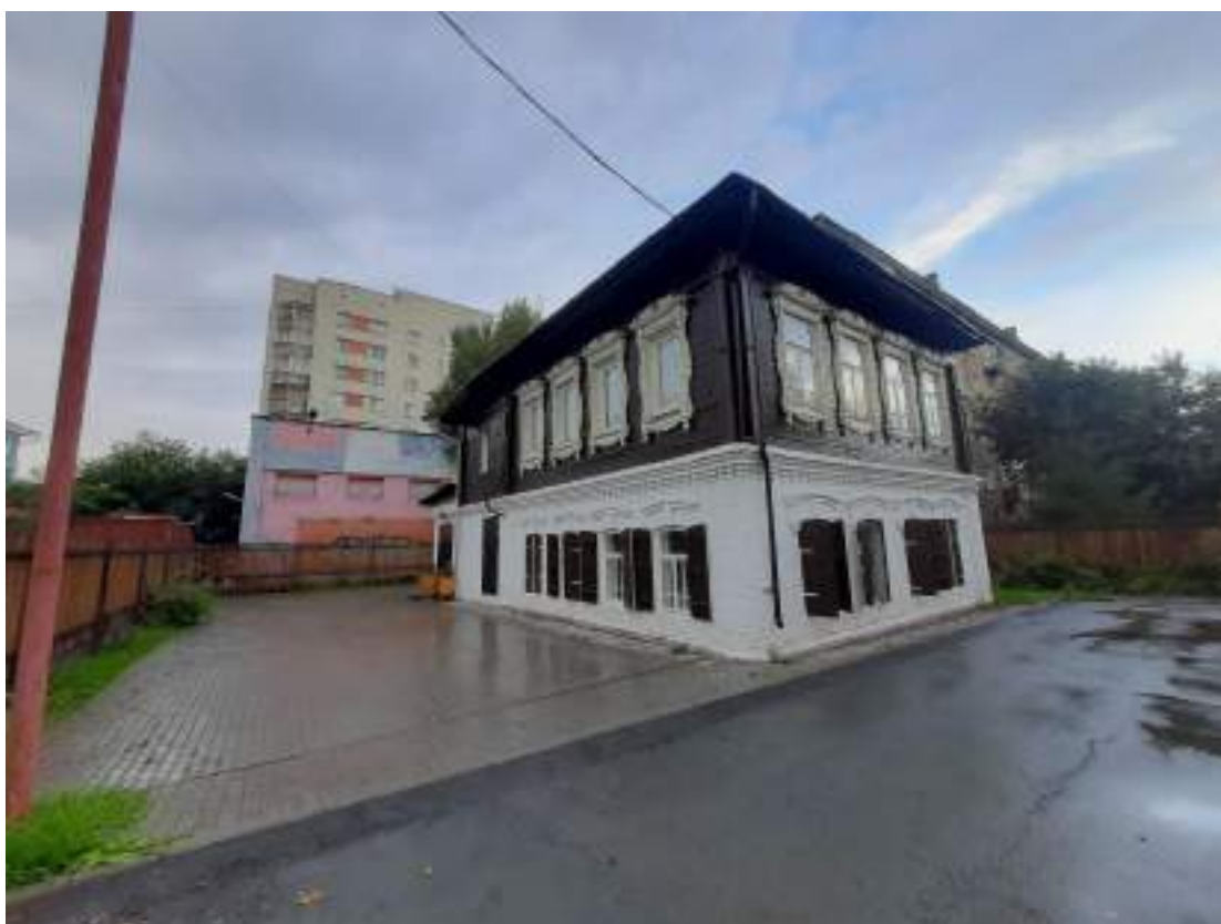
Фото 2. Вид на объект культурного наследия местного значения «Дом жилой Д.Е. Барабанова». Фото от 05.09.2023г.
