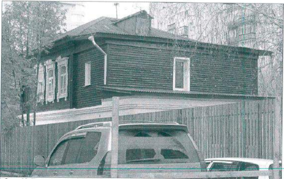
Фото 13. Вид крыши с юго-запада.
