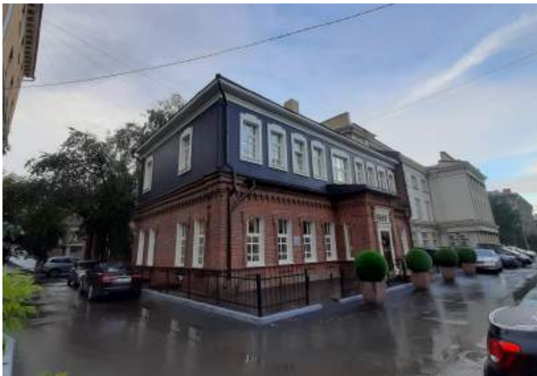
Фото 5. Вид на объект культурного наследия регионального значения «Смешанный 2-этажный дом», с четной стороны ул. Потанинская. Вид на северный и восточный фасады. Фото от 05.09.2023 г.
