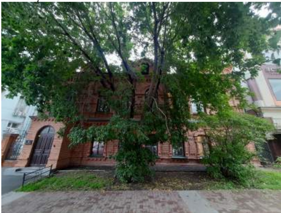
Фото 14. Вид на объект культурного наследия регионального значения «Двухэтажное кирпичное здание». Вид на южный фасад. Фото от 05.09.2023 г.
