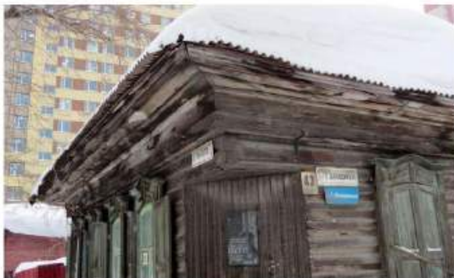
Вид и состояние скошенного угла южного и восточного фасадов. Январь 2018 года.
