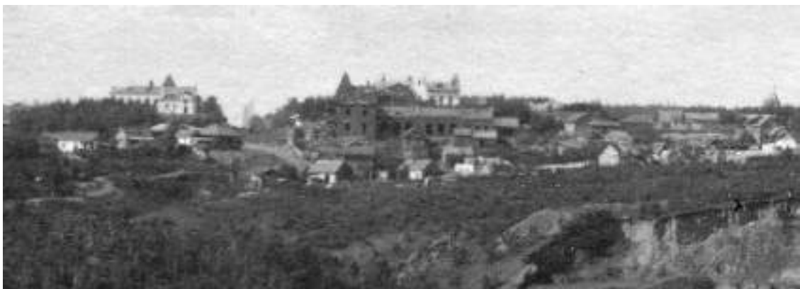
Рис. 15. Строительство второго корпуса заразной больницы. 1916 – 1917 гг.
