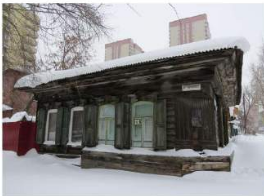
Вид и состояние южного фасада. Январь 2018 года.
