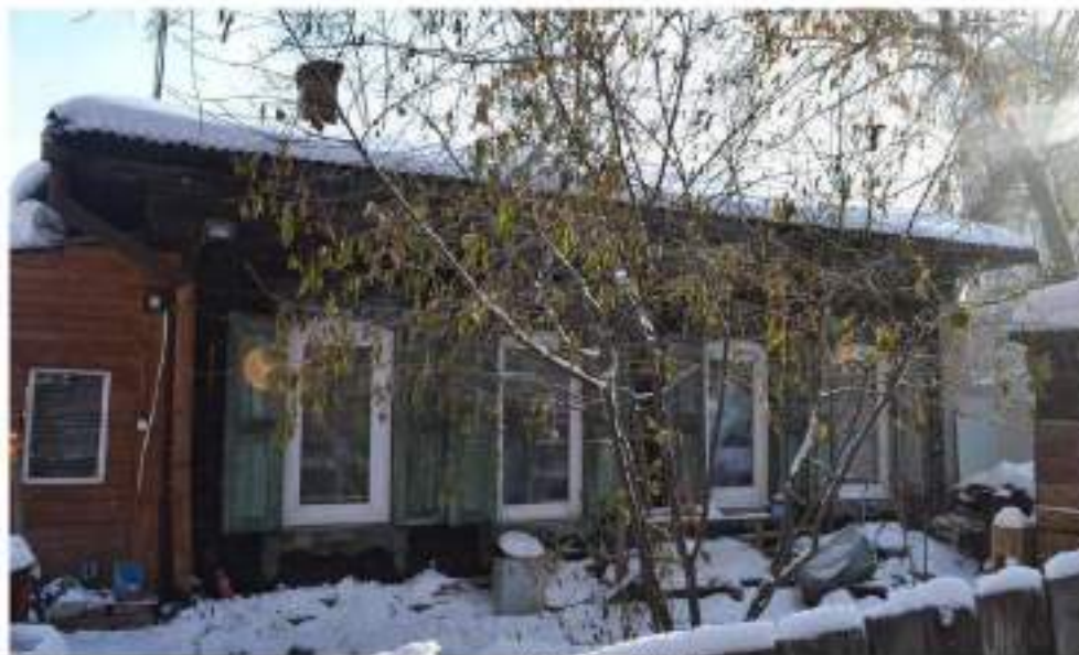
Вид и состояние западного фасада. Ноябрь 2018 года.
