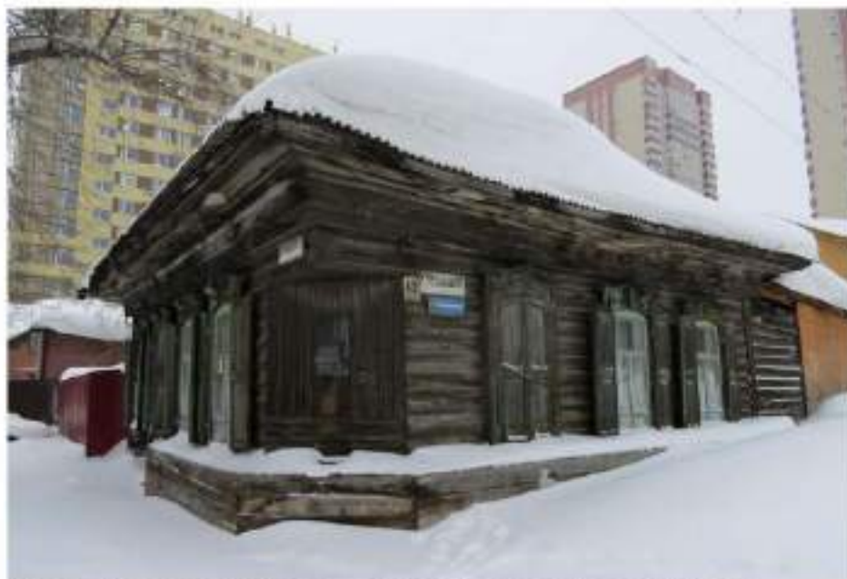
Вид и состояние южного и восточного фасадов. Январь 2018 года.
