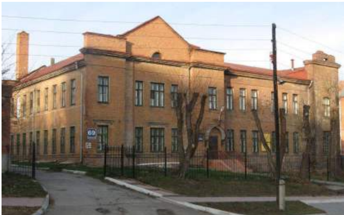
Рис. 16. Второй корпус заразной больницы (ул. Ядринцевская, 69). Фото октябрь 2008 г.
