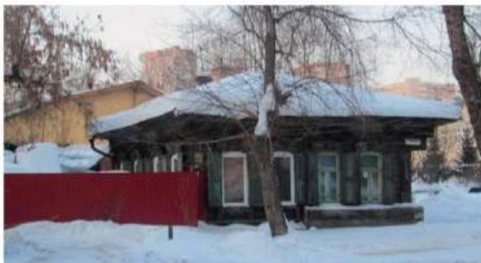
Вид и состояние южного и западного фасада. Февраль 2018 года.
