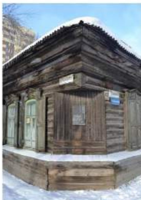
Вид и состояние скошенного угла, прямых венцов и карниза со стороны южного и восточного фасадов. Ноябрь 2018 года.
