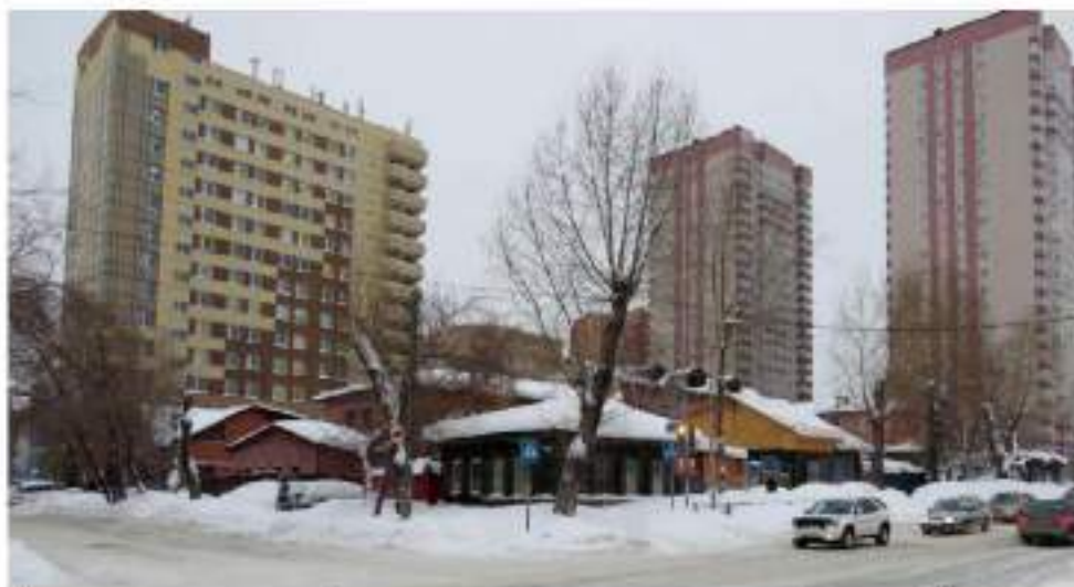
Вид и состояние объекта в ситуации современной застройки. Перекресток улиц Ядринцевской и Семьи Шамшиных. Январь 2018 года.
