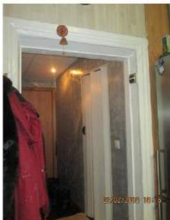
Вид и состояние дверного проема в входную зону северного фасада. Февраль 2018 года.
