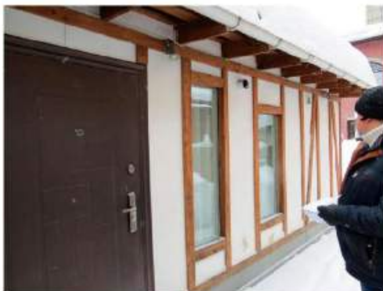
Вид и состояние пристройки северного фасада. Январь 2018 года.
