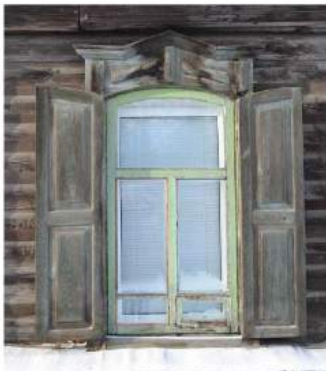
Вид и состояние оконного переплёта, ставен и наличника окна восточного фасада. Ноябрь 2018 года.
