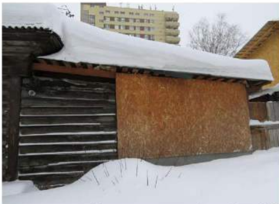
Вид и состояние пристройки со стороны восточного фасада. Январь 2018 года.
