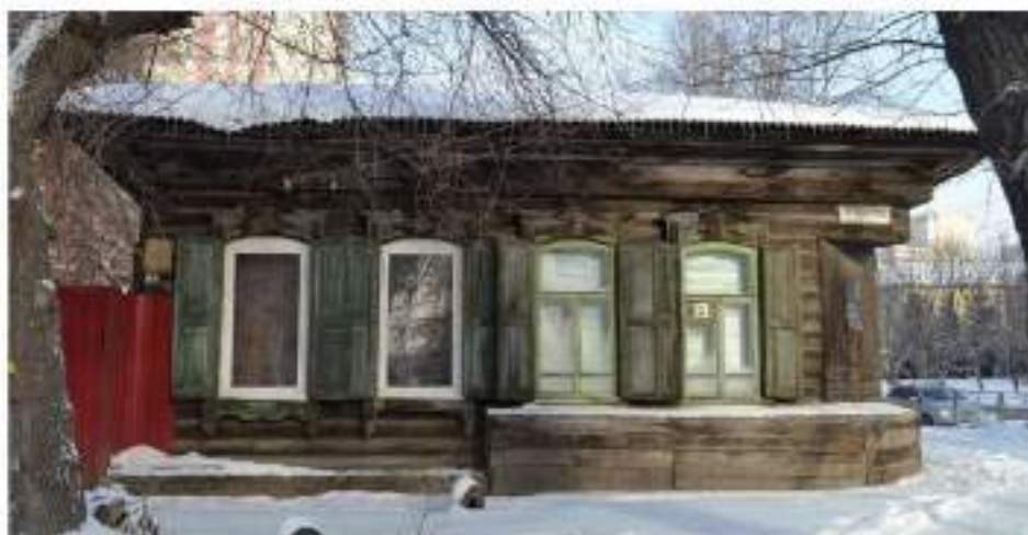
Вид и состояние южного фасада. Ноябрь 2018 года.
