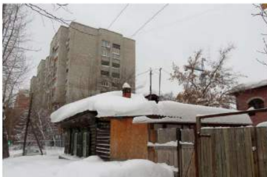
Вид и состояние восточного и северного фасадов. Январь 2018 года.
