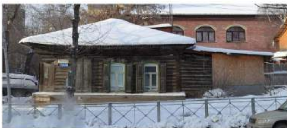
Вид и состояние восточного фасада. Ноябрь 2018 года.
