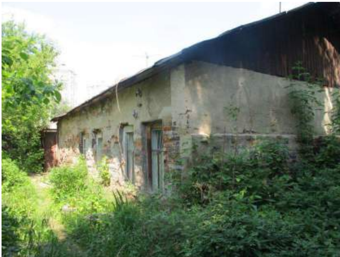
Фото №83, июнь 2023г. Жилой дом по адресу: ул. Романова, 72.
