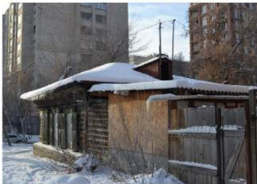
Вид и состояние восточного фасада и пристройки северного фасада. Ноябрь 2018 года.
