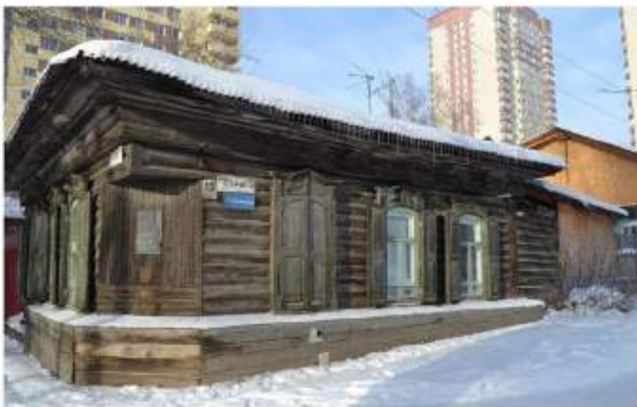
Вид и состояние восточного и южного фасадов. Ноябрь 2018 года.
