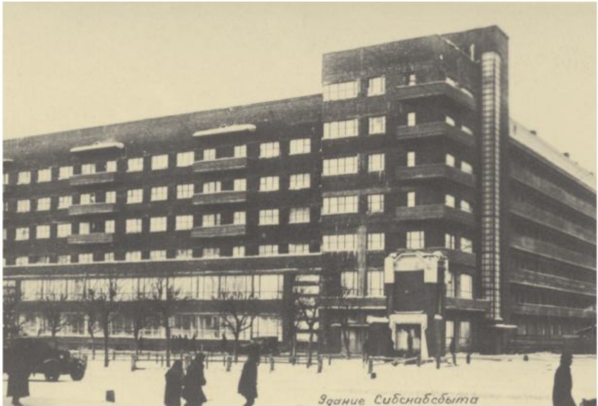
72. «Дом с часами» (Красный проспект, 11) Вид с Красного проспекта. Фотография середины 1930-х гг.
