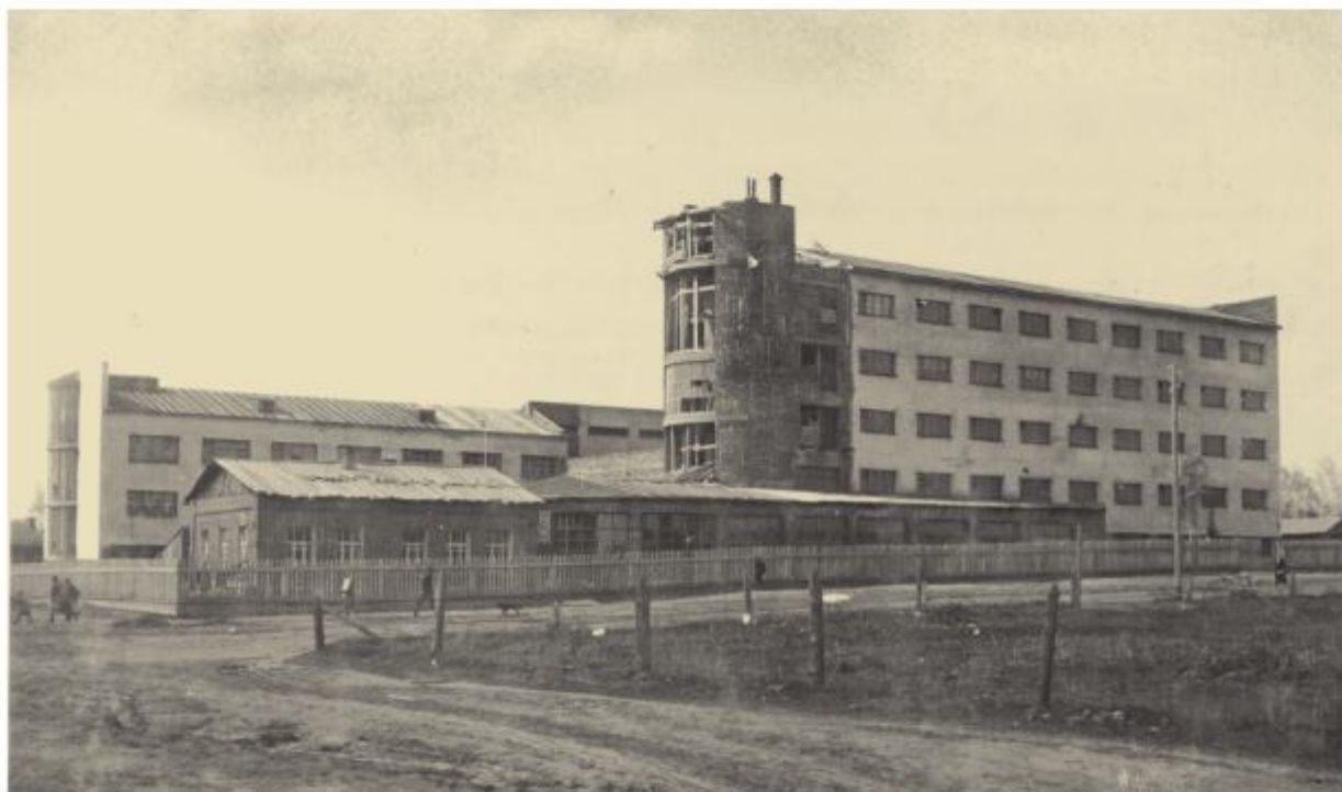
117. Химико-политехнический техникум (ул. Садовая, 26) Вид с ул. Сакко и Ванцетти. Фотография начала 1930-х гг.
