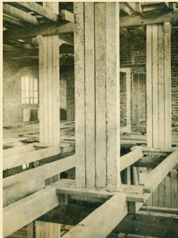
Строительство жилого дома ЖСКТ «Политкаторжанин». Сборно-стоечные колонны инженера Н.В. Никитина. // ГАНО. Ф. Р-1594. Оп. 1. Д. 28. Л. 32.
